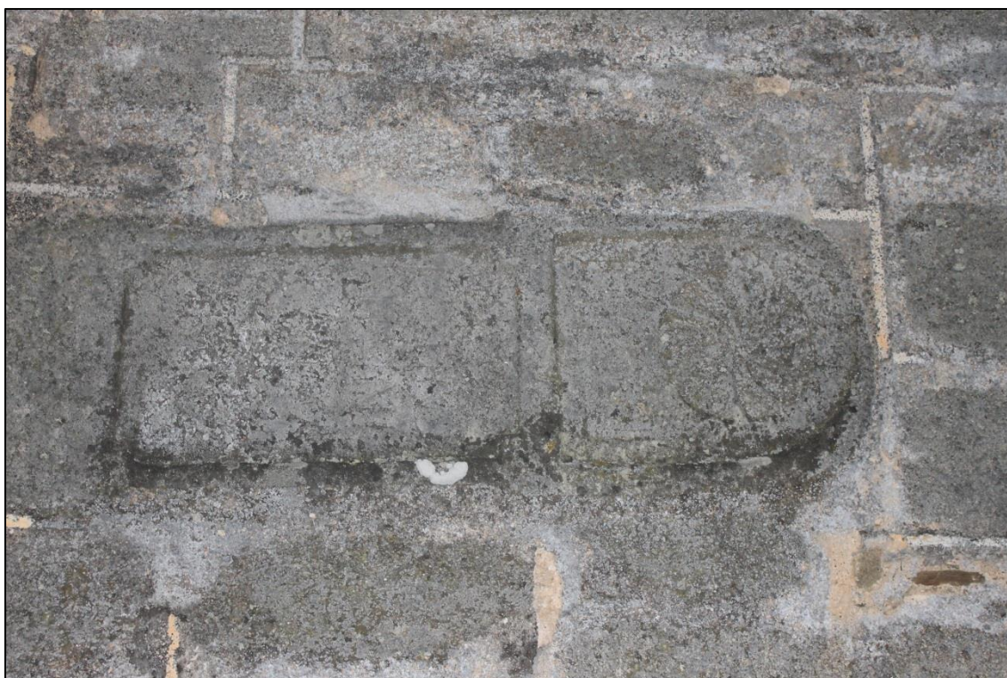
Fig. 106. Estela romana situada en posición secundaria junto a la Iglesia de Rabanales.
