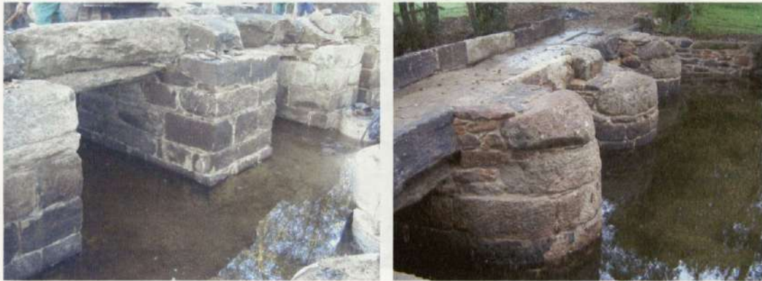
Detalle de colocación del petril.
