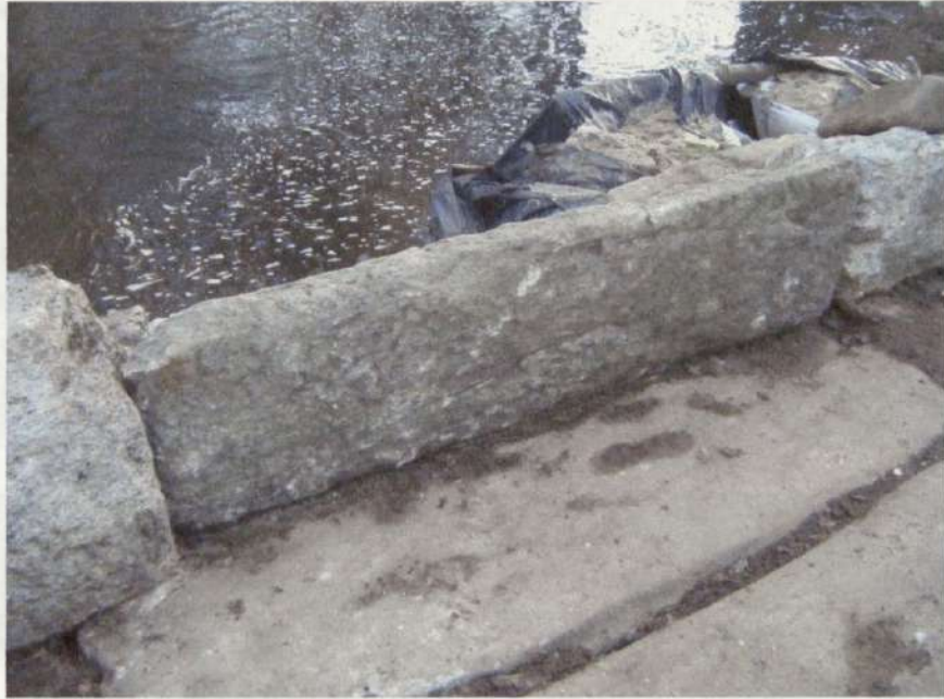
Detalle de colocación del petril.
