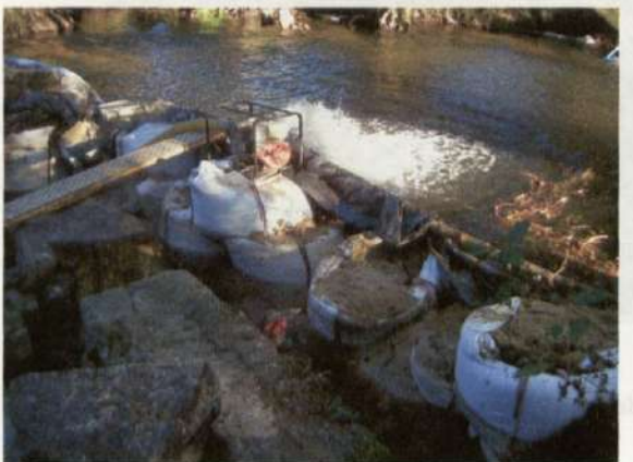
Detalle de construcción de ataguías y electrobombas
