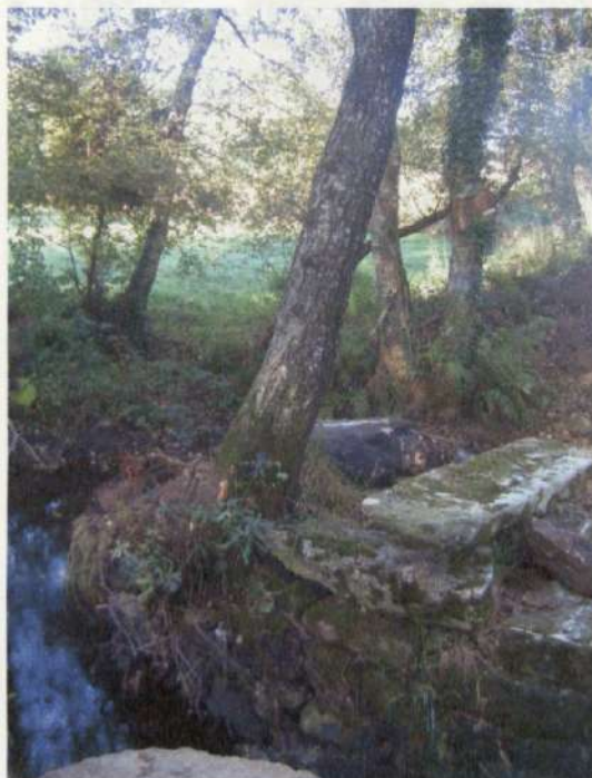
Estado actual de los tocones y árboles enraizados en la fábrica del puente
