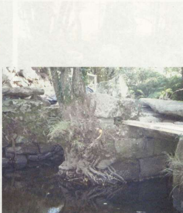
Estado actual de los tocones y árboles enraizados en la fábrica del puente
