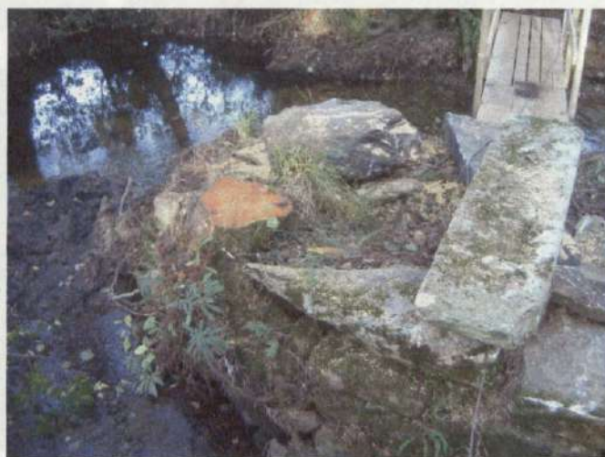
Tareas de corte y de limpieza
