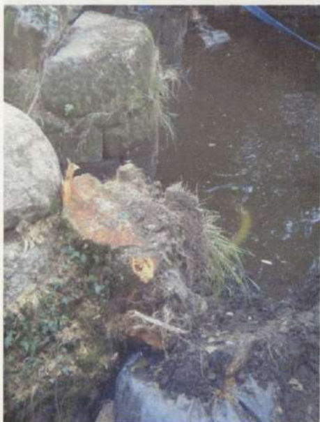
Estado actual de los tocones y árboles enraizados en la fábrica del puente
