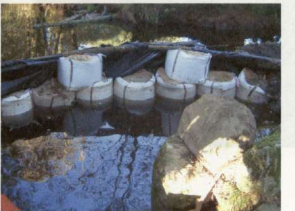
Detalle de construcción de ataguías y electrobombas
