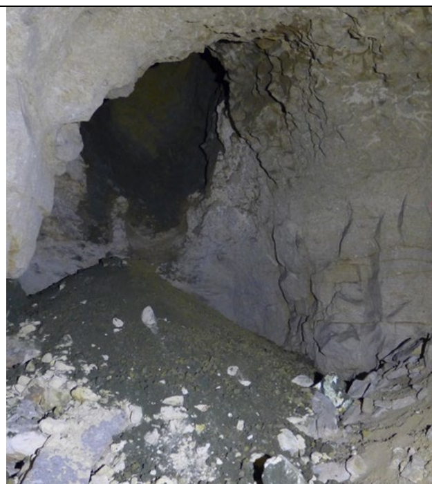
Vidange d'une poche karstique dans des galeries, à -15 m (Cuesmes, Formation de Ciplly-Malogne, photo SPW, SGW)
