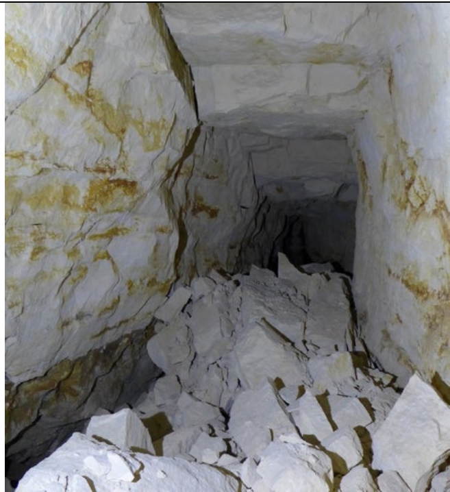
Eboulis sous remontée de fontis ayant rejoint le toit de la galerie (fontis linéaire sur faille, Cuesmes, photo SPW, SGW)
