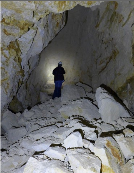
Remontée de fontis et ses éboulis de pied (fontis linéaire sur faille, Cuesmes, photo SPW, SGW)
