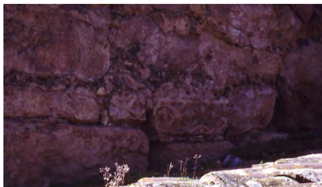
Figs. 33 y 34. Cimacios visigodos reutilizados en la construcción de la muralla de Talamanca del Jarama.
