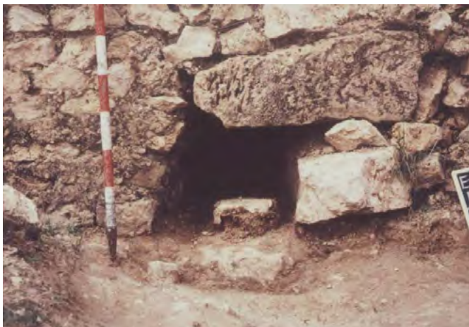
Fig. 439. Ercávica. Baños. Detalle de los pilares que apuntalan la estructura. La nueva sin moldura hidráulica.
