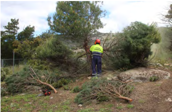
Fig. 52. Trabajos de desbroce de los elementos arbóreos.
