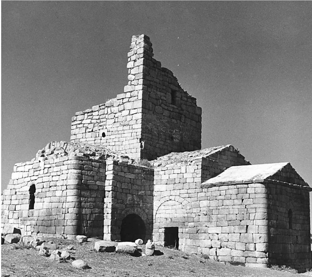
Fig. 521. Santa María de Melque antes de su restauración.
