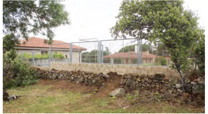
Fig. 51. Reconstrucción de la valla ganadera sita al oeste de la finca.
