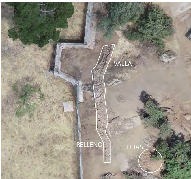
Fig. 56. Reconstrucción de la valla ganadera situada al oeste y relleno con tierra procedente de la excavación.
