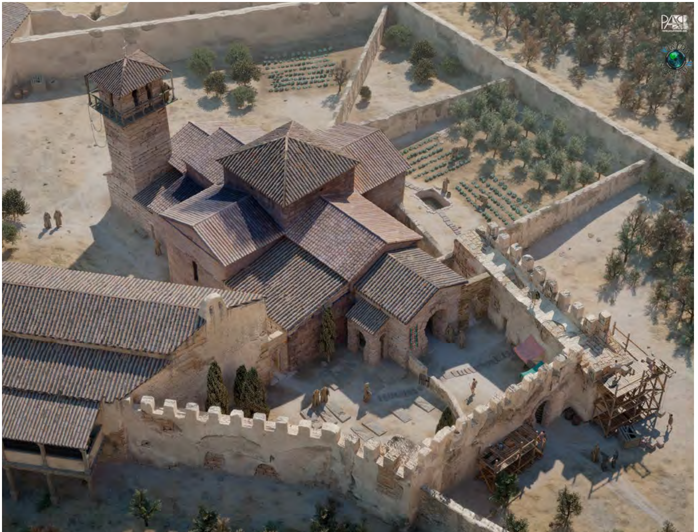
Figs. 540 y 541. Entorno del complejo y reconstrucción 3D.
