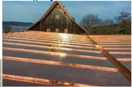
Umbau am Käppeliweg in Männedorf
