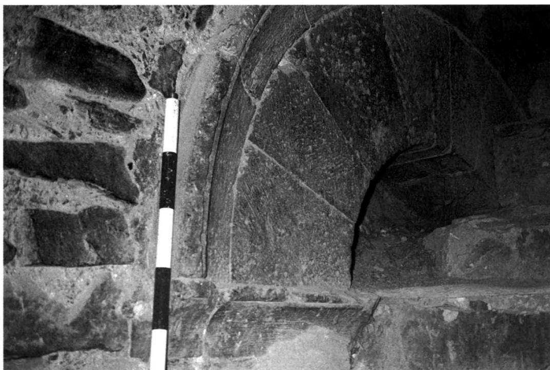
Arco de medio punto de la primitiva entrada a la iglesia, cubierto por la escalera de acceso al campanario.
