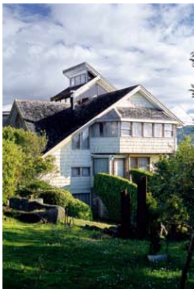
Casa del Obispo en Ancud. The Bishop's House in Ancud.
