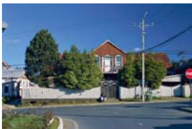
145 Casa en calle Centenario. Acceso a Chonchi. 3E
