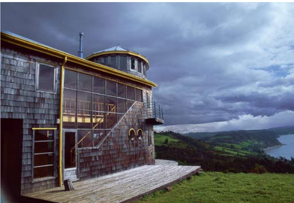
Arriba, Casa Barco. Arquitecto Edward Rojas. En el sector de Huenuco, comuna de Castro.
