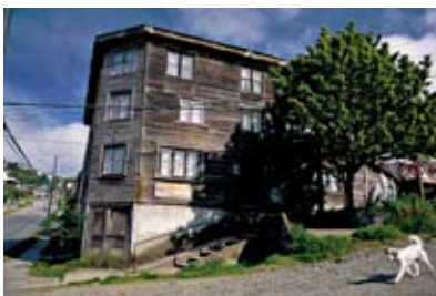
230 Casa con cuatro pisos. Puerto Montt. 2A
