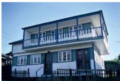
167 Casa corredor. Quellón. 3F
