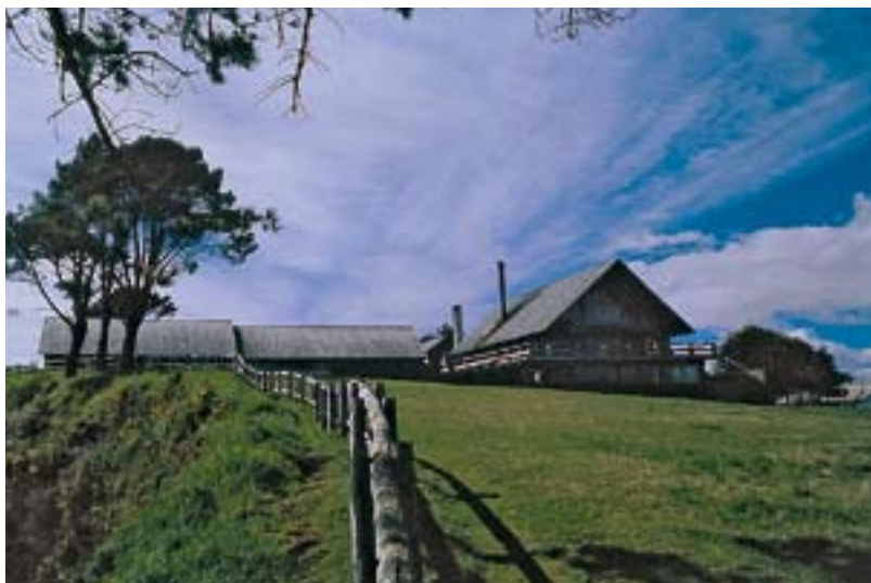
Hostería de Ancud, del arquitecto Emilio Duhart. Ancud Guesthouse, by the architect Emilio Duhart.
