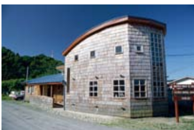
156 Biblioteca municipal. Arq. Rojas y Retamal. Queilen. 2E
