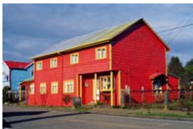
210 Casa dos miradores. Chacao. 3B
