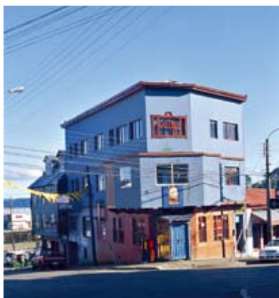
202 Edificio Cobus. Ancud. 3L
