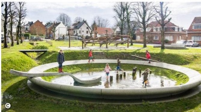
Laagteberging en infiltratie in het openbaar domein. Wadi's in Kruisem – Nerethstraat en Steenoven (boven) en Edegemsesteenweg Kontich (onder) (Bron: gemeente Kruisem en blauwgroenvlaanderen.be)
