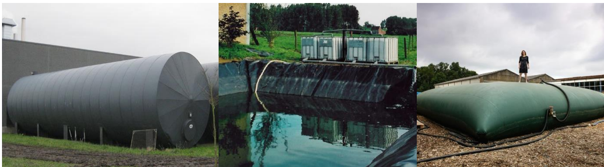
Buffertanks, een foliebekken en een zak, voor de opslag van regenwater (Bron: Sumaqua & ZES, 2021).
