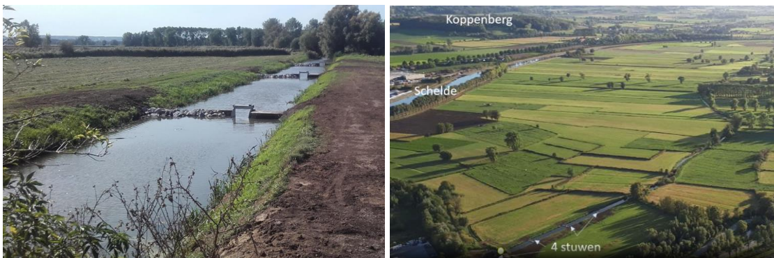
Aanleg van visdoorlatende stuwen in de Langemeersen, Oudenaarde (Bron: Van Braeckel – INBO & Malfroid – Provincie Oost-Vlaanderen, 2021).
