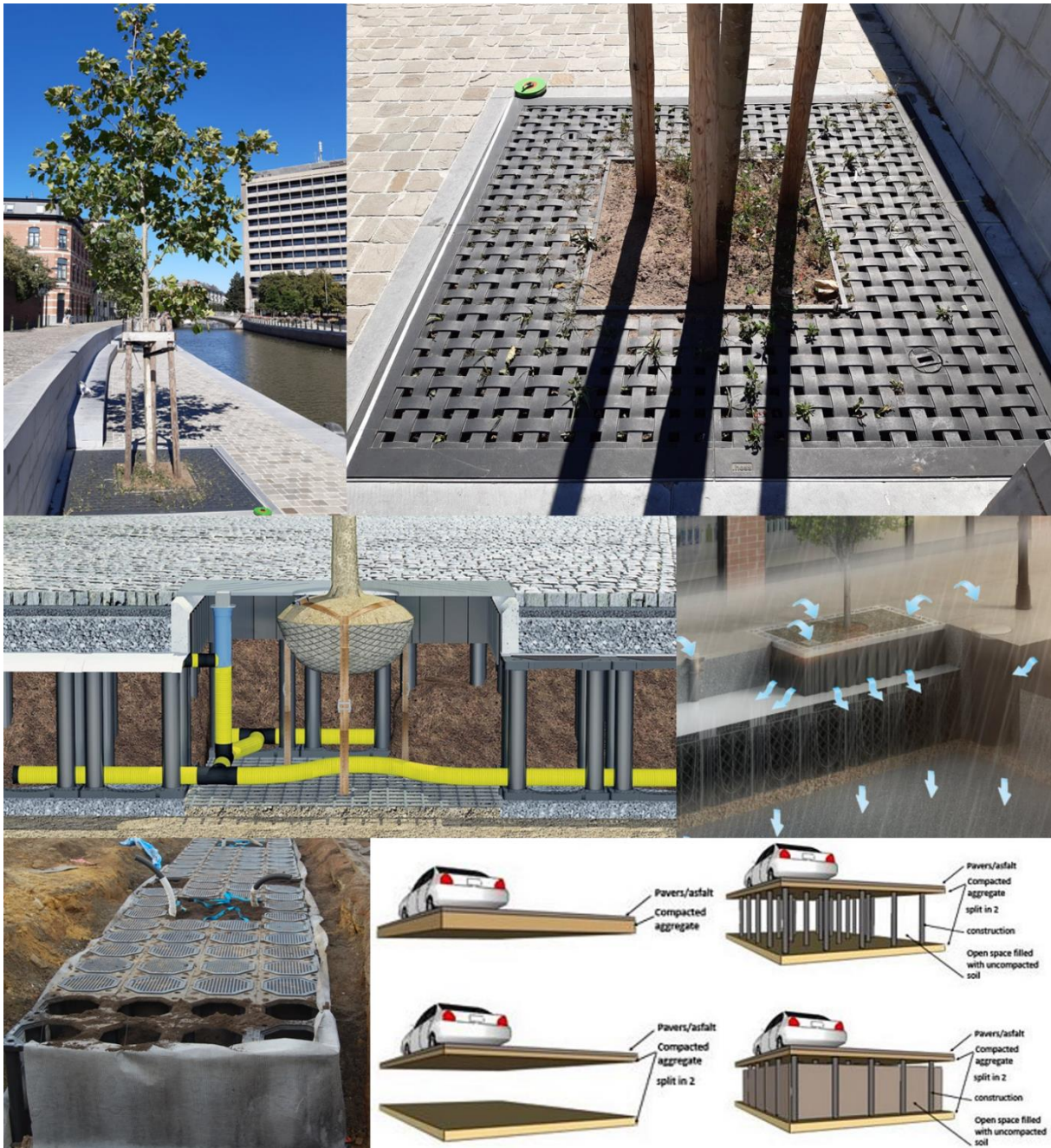
Voorbeelden van manieren om de boom meer wortelruimte te geven en meer infiltratieoppervlakte te behouden zonder gebruiksbeperkingen op de ruimte te leggen. Bovenste rij: boomspiegels die deels afgedekt zijn met doorlatend rooster te Reep, Gent (Bron: Provincie Oost-Vlaanderen). Onderste 2 rijen voorbeelden van boombunkers die zorgen voor een grote doorwortelbare ruimte zonder risico op wortelopdruk (Bronnen: Greenmax, 2021 en Greenblue Urban, 2021).
