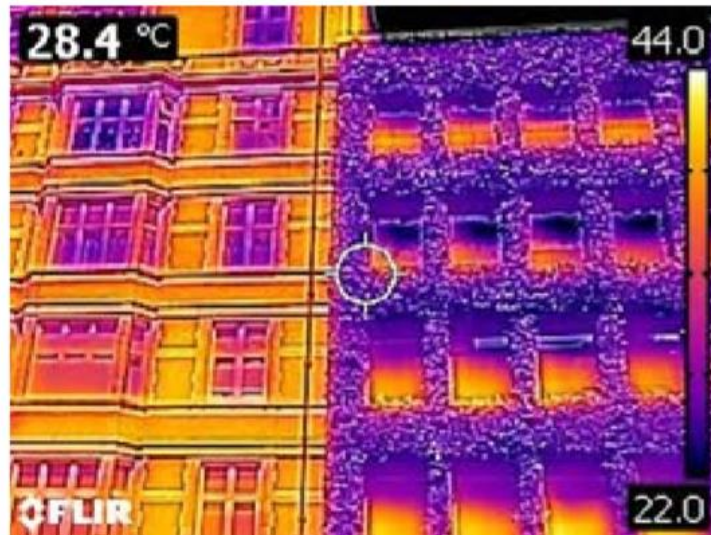
Thermografisch beeld van groengevel en “klassieke” niet vergroende gevel. De temperatuur in de linkerbovenhoek is de temperatuur gemeten in het centrum van de foto (in dit geval dus op de groene gevel). Rechts in beeld staat de kleurschaal die van toepassing is op deze foto (Bron: Razzaghmanesh & Razzaghmanesh, 2017).
