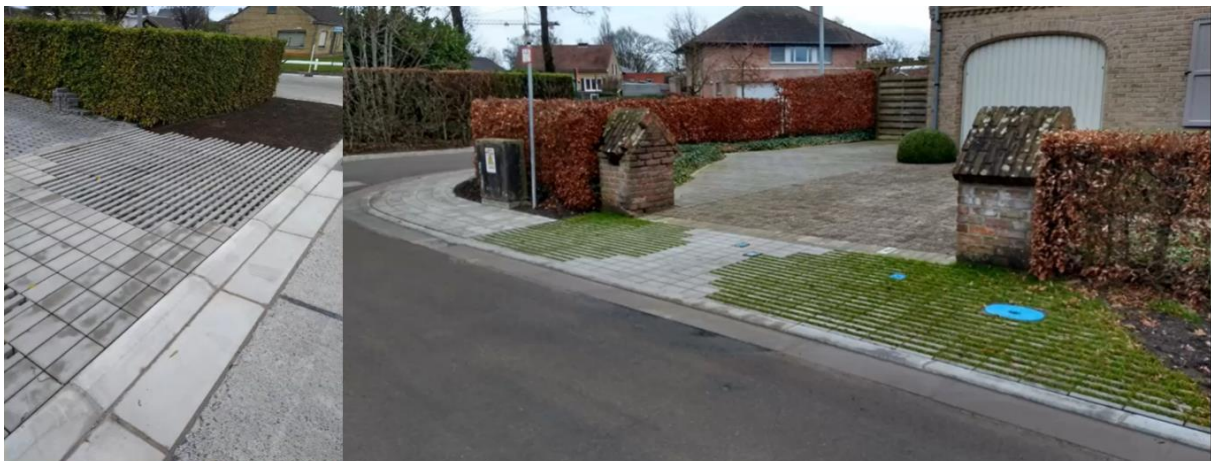
Voorbeelden van deel van het wegprofiel in waterpasserende verharding, met behoud van gebruiksvriendelijke toegankelijkheid. (Bron foto's: Aquafin).
