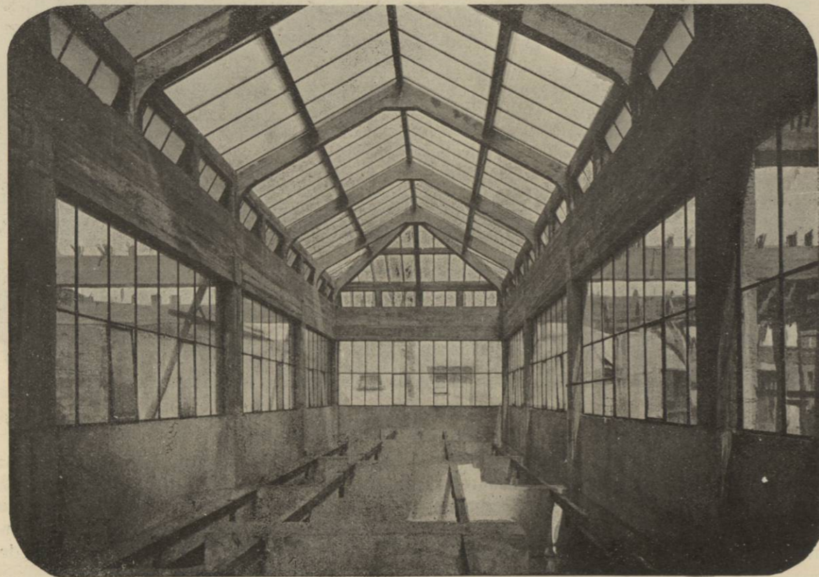
Fig. 3. — Galerie vitrée au dessus de la voûte centrale.
