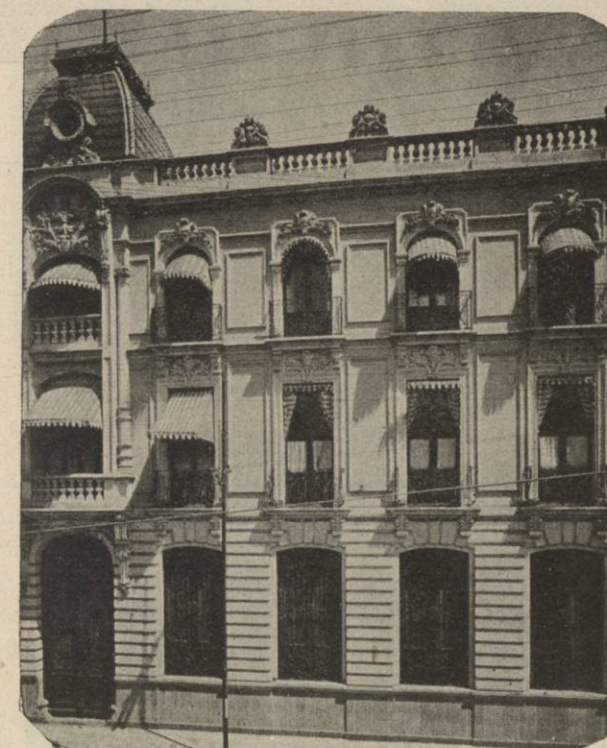
Fig. 8. — Fondations en radier, poteaux de 15 centimètres masqués dans les murs en briques, escaliers, planchers et terrasse en béton armé. Cette maison a résisté à un fort tremblement de terre sans avoir eu la moindre trace de fatigue. Propriétaire : M. Hijo de A. Escandon. Architecte : M. A. Del Rio. Concessionnaire : M. A. O. Monasterio, à Mexico.
