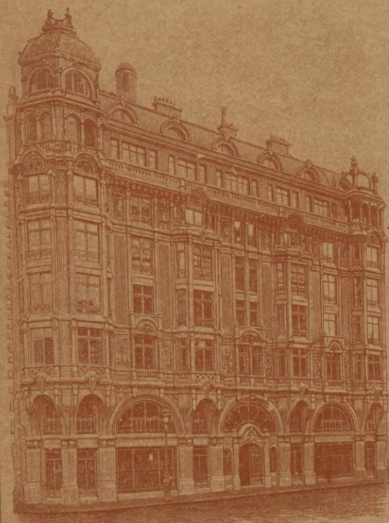
Immeubles du Bureau technique central.
