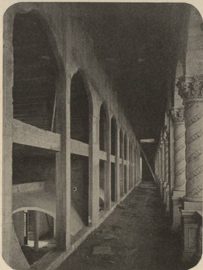
Fig. 13. — Loggia en béton armé.
