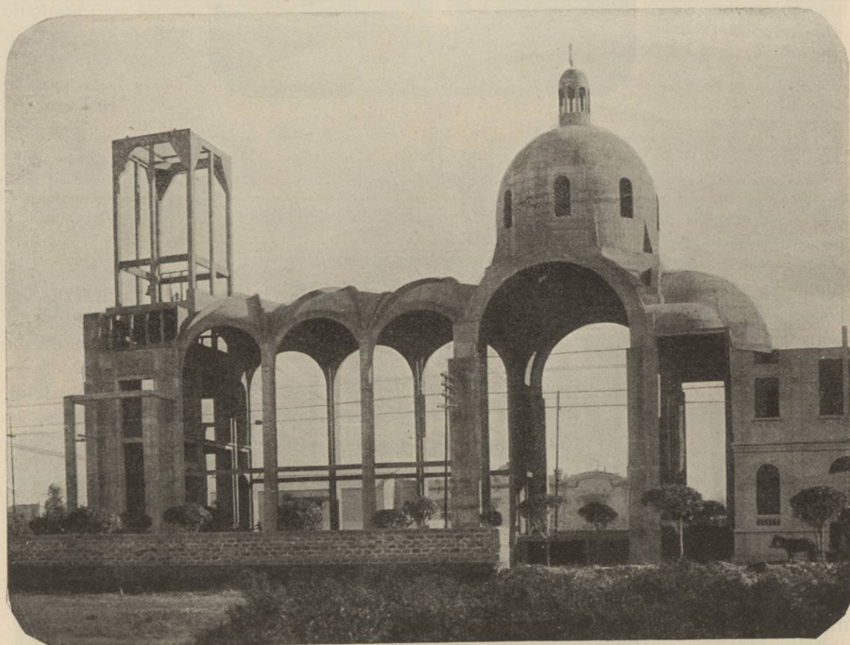
Fig. 6. — Ossature, planchers et fondations en béton armé. Hauteur de la flèche de la tour, 55 mètres.
