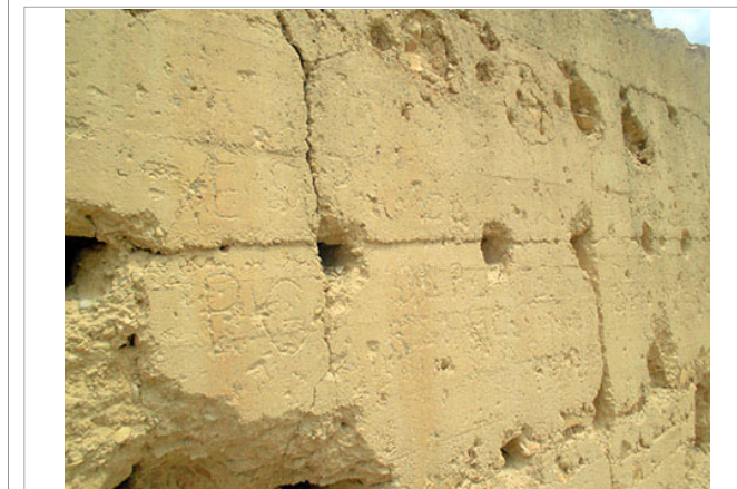
Lienzo de tapial calicostrado de la torre andalusí
