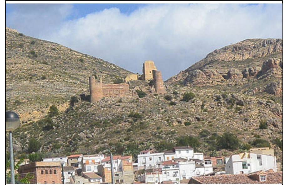
Vista desde el sur donde se aprecia la relación con el núcleo urbano
