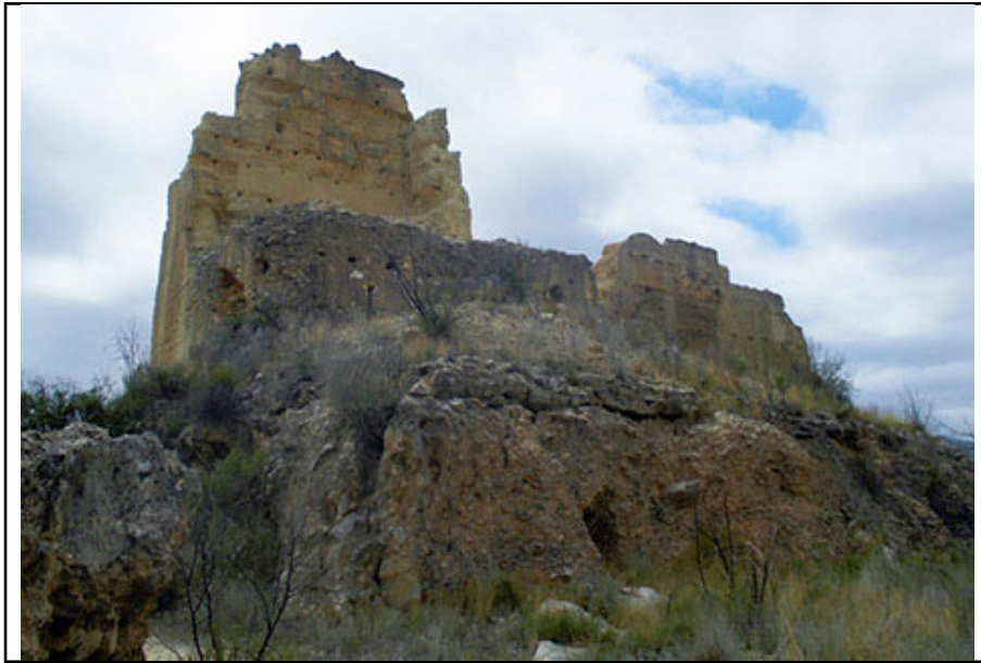
Vista desde el norte de la torre y recinto andalusí
