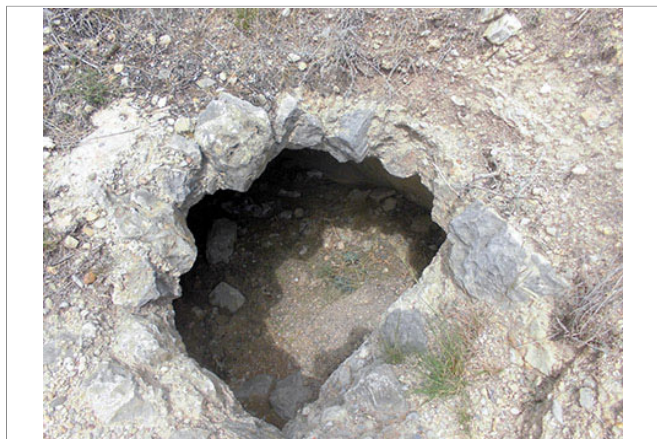
Hueco por el que se puede acceder al aljibe
