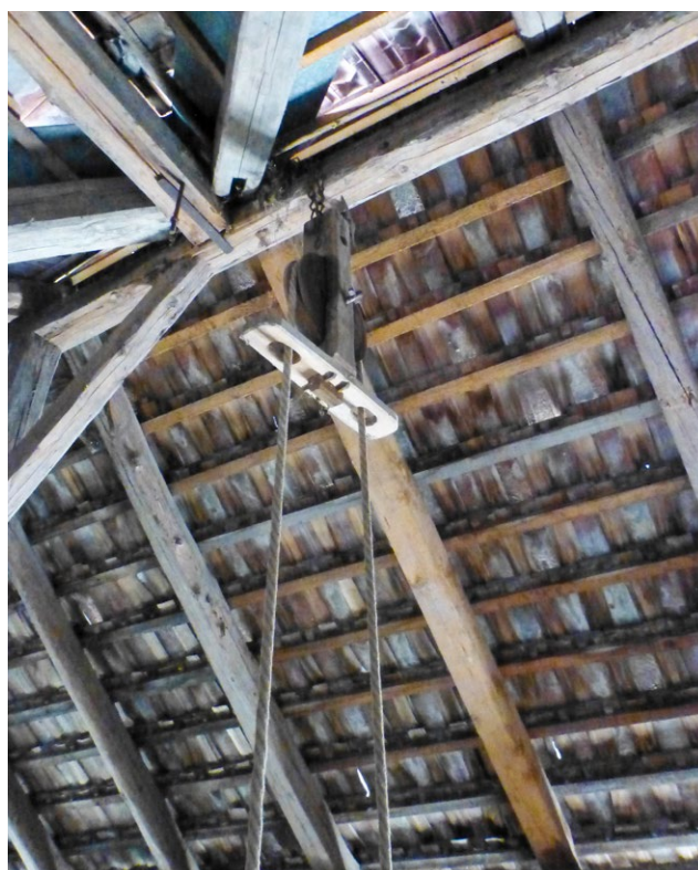
Das Brügelseil – erleichtert das Be- und Entladen von Gütern.
