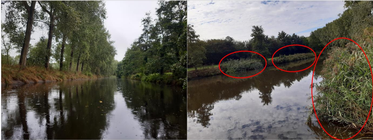
Figuur 10: Links: locatie 618 met betonnen oeverversteving zonder vooroever. Rechts: locatie 619 waar vooroevers met riet (rood omlijnd) een natuurlijker resultaat opleveren. Bron foto: © Mechtild Zoeter Vanpoucke, PCM.
