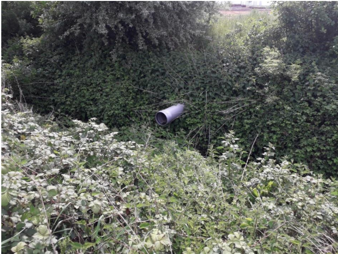
Figuur 13: Onbekend lozingspunt stroomopwaarts van locatie 436. Op moment van plaatsbezoek was het niet duidelijk of het al dan niet om afvalwater ging.
