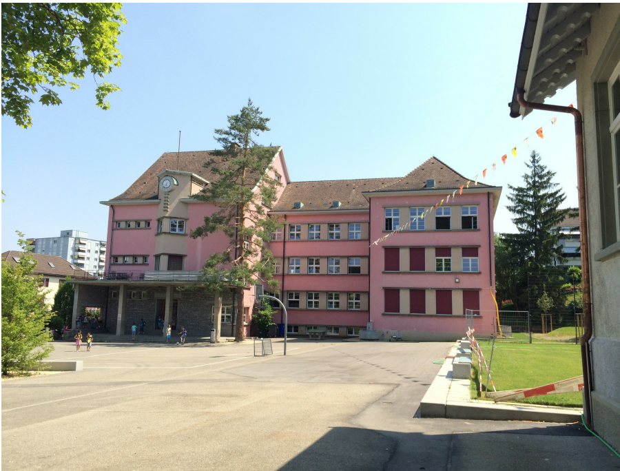
Primarschulanlage Schulstrasse, Rotes Schulhaus (Vers. Nr. 00802), Ansicht von W, 12.06.2014 (Bild Nr. D100659_74).
