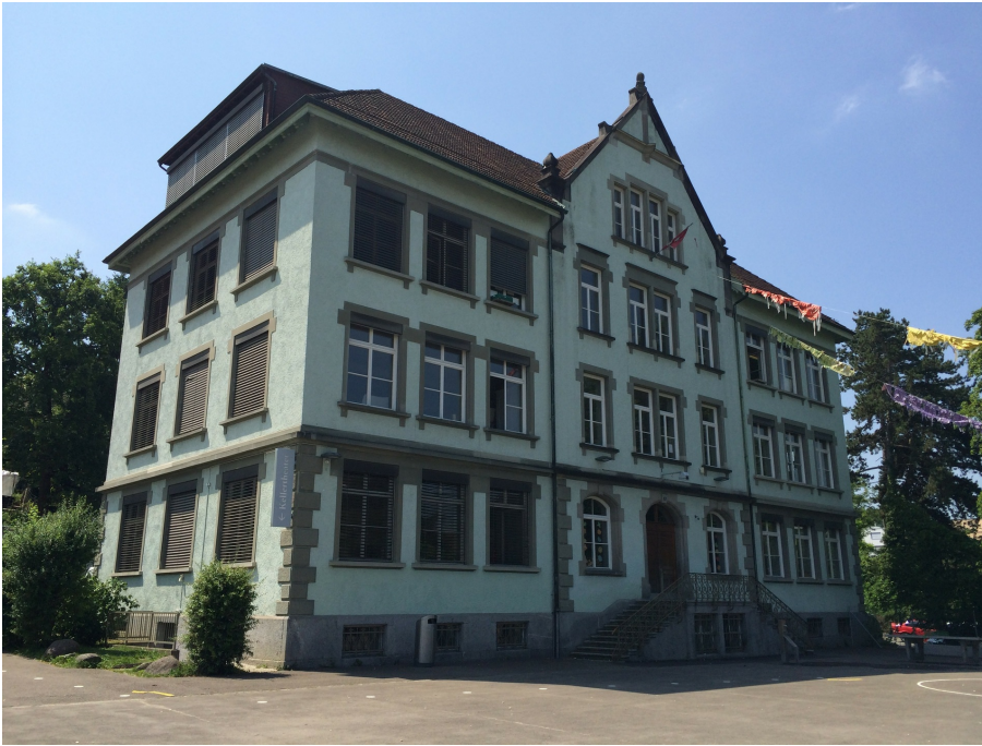
Primarschulanlage Schulstrasse, Schulhaus Grabenstrasse (Vers. Nr. 00366), Ansicht von NO, 12.06.2014 (Bild Nr. D100659_69).
