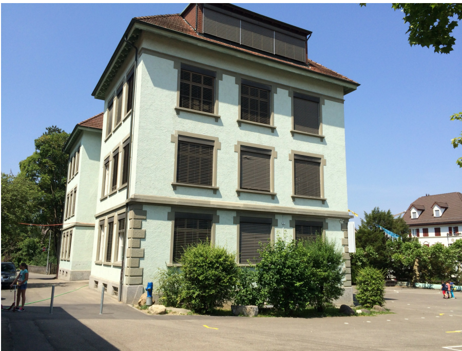
Primarschulanlage Schulstrasse, Schulhaus Grabenstrasse (Vers. Nr. 00366), Ansicht von O, 12.06.2014 (Bild Nr. D100659_71).
