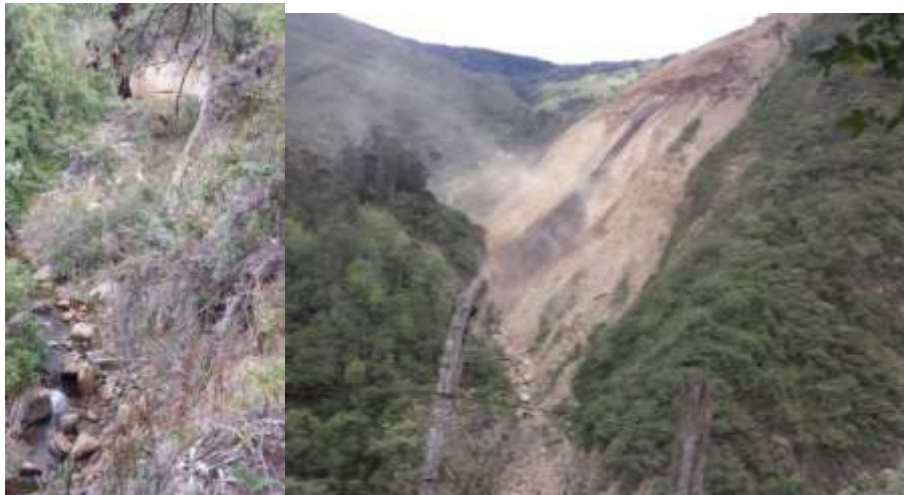
Fotografía N° 1. Vías de acceso interrumpidas por deslizamientos.
