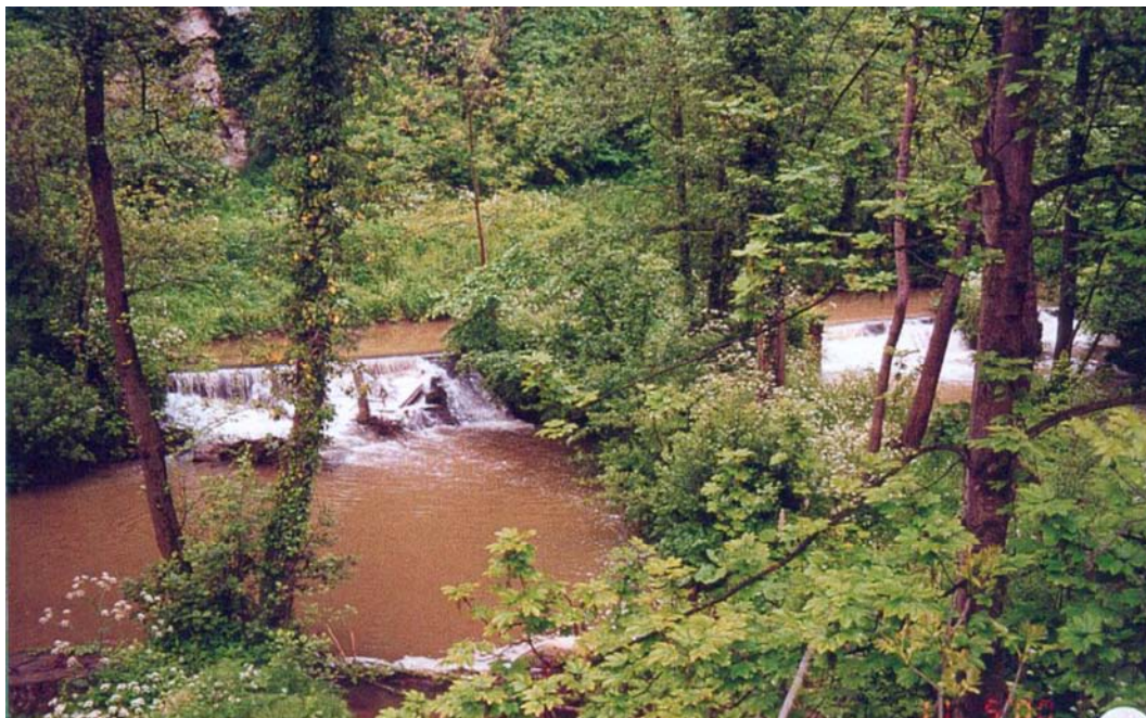
Figure 44. Le barrage de Moha Four à chaux sur la basse Méhaigne
