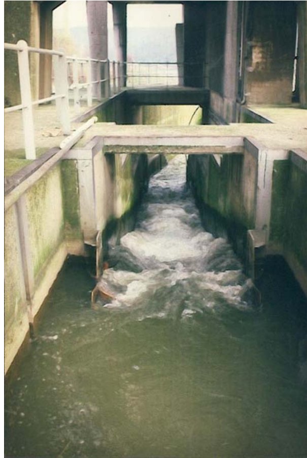
Figure 16 . Ancienne échelle à poissons à ralentisseurs (Denil) du barrage d'Ampsin-Neuvville sur la Meuse. Vue vers l'aval à partir du bassin supérieur vidangeable pour le contrôle.
