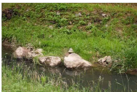
hauteur d'eau de 0,50m
