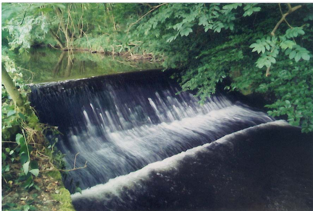
Figure 28. Le barrage de Neufchâteau (2 ème catégorie), un obstacle majeur à la remontée de l'anguille dans la haute Berwinne à 14,6 km de l'embouchure.
