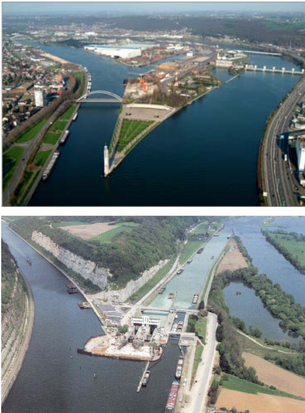
Figure 27. Le canal Albert au niveau : (au-dessus) à son entrée en rive gauche de la Meuse à Liège et (en-dessous) au niveau de la tranchée de Caster (en direction d'Antwerpen et de l'Escaut) et de l'écluse de Lanaye (retour vers la Meuse néerlandaise à Maastricht)
