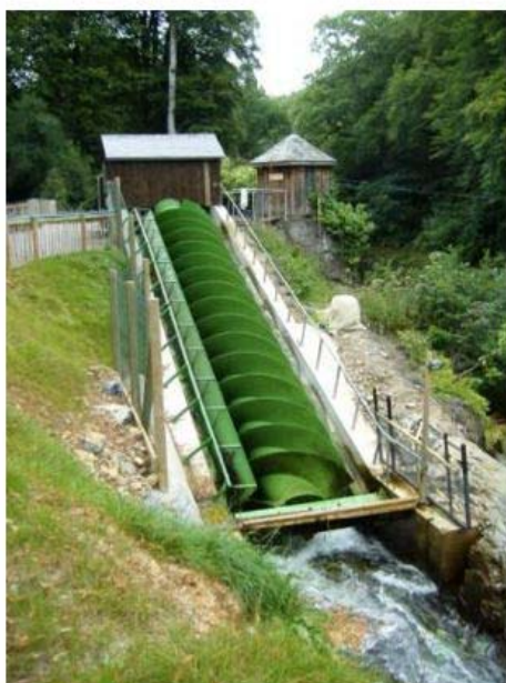
Figure 80. Modèle de turbine hydroélectrique en vis d'Archimède considérée comme ichthyocompatible, c'est-à-dire ne causant pas de dommages aux poissons qui la traversent
