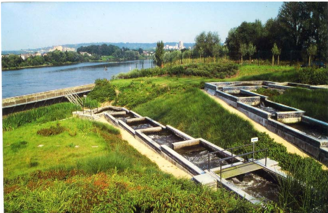
Figure 18. Nouvelle grande échelle à poissons du barrage de Lixhe construite par le MET en 1998.
