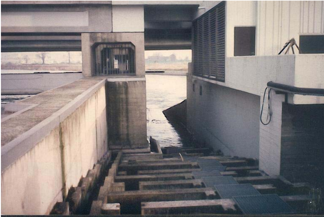
Figure 17. Ancienne petite échelle à poissons du barrage de Lixhe construite à l'origine en 1980 entre les déversoirs du barrage et la centrale hydro-électrique.
