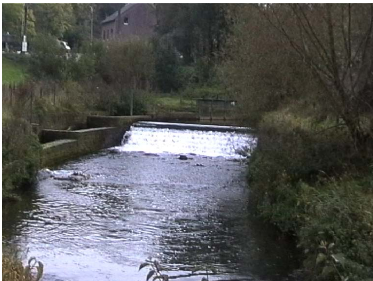
Figure 32 A. Le barrage de Sippenaeken, équipé d'une échelle à poissons, premier obstacle à la remontée de l'anguille dans la partie wallonne de la Gueule.
