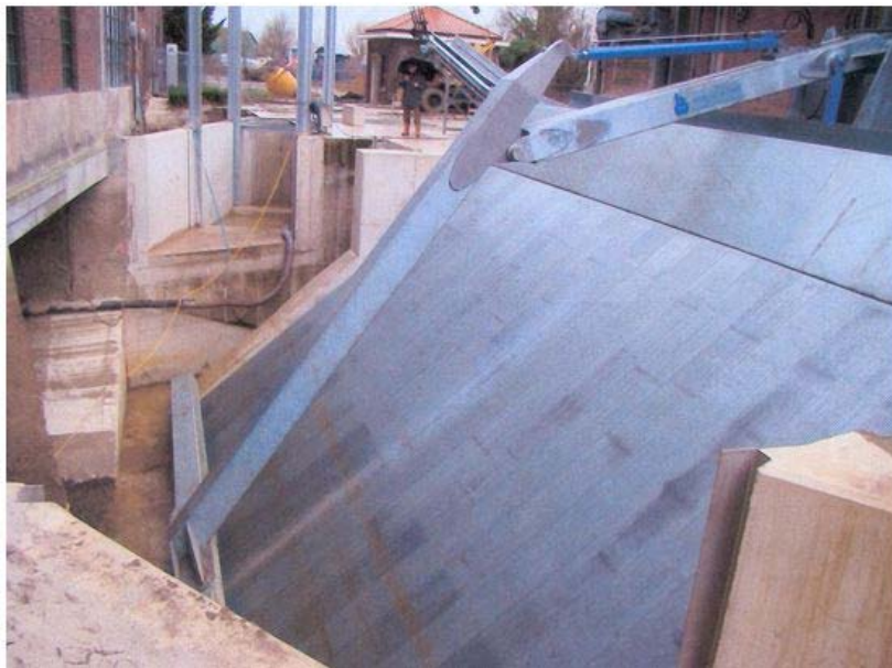
Figure 79. Exemple de grille fine (barreaux espacés de 1 cm) placée devant les turbines d'une nouvelle centrale hydroélectrique (18 m 3 /s) sur la Roer à Roermond aux Pays-Bas (projet Life). Les poissons migrateurs bloqués par la grille ont la possibilité de contourner l'obstacle par un canal latéral constituant un exutoire de dévalaison (Philippart et Ovidio, 2009).
