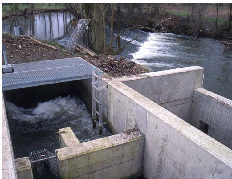
Figure 30. Echelle à poissons avec piège de capture au barrage de Berneau sur la Berwinne
