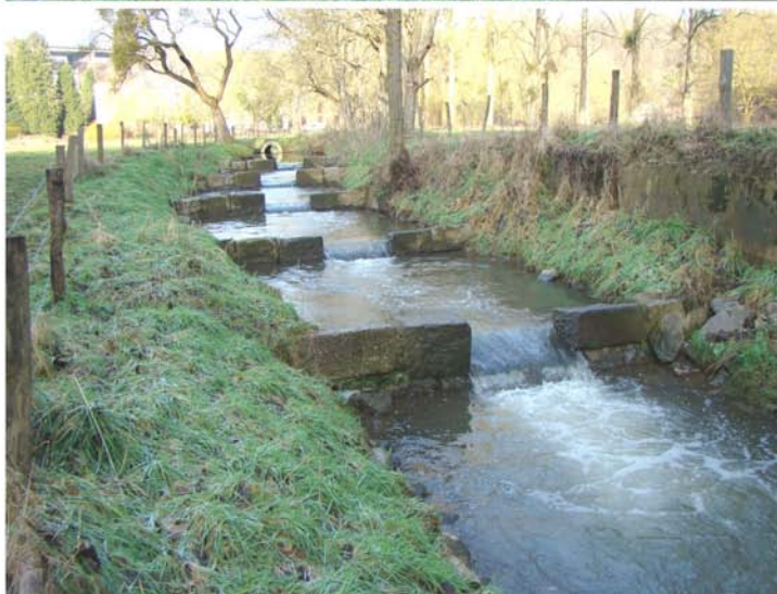
Figure 45 B. Le barrage hydroélectrique Collinet à Huccorgne et sa nouvelle échelle à poissons de contournement construite par la DCENN du SPW.( source : Ovidio et al., 2009)
