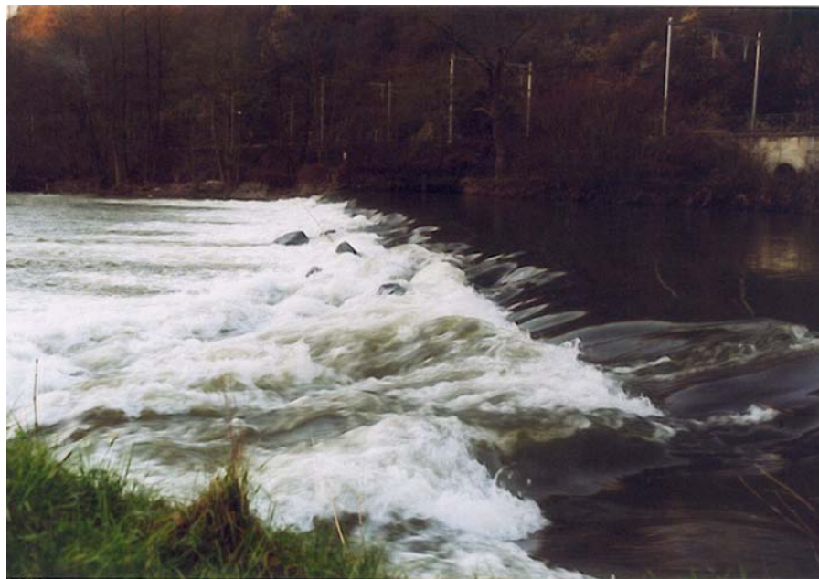
Le seuil en enrochements de Belle Roche (Comblain–au-Pont), premier obstacle depuis l’Ourthe
