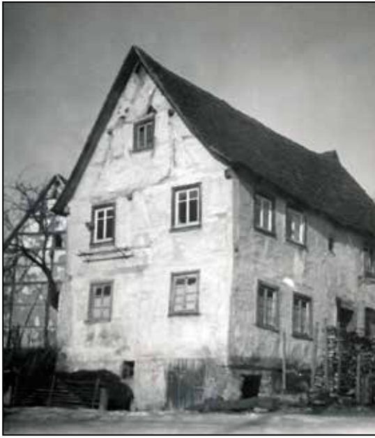
Einmündung Mauerstraße in die Kirchenstraße
