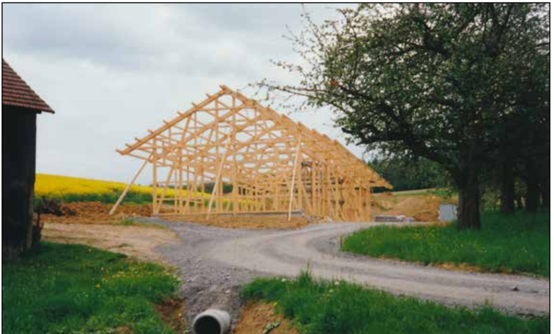
Aufschlag Gemeinschaftsscheuer. Im Rahmen der Flurbereinigung wurde durch die Betriebe Fugger, Hebeiß und Kühner eine gemeinschaftliche Maschinenhalle errichtet.
