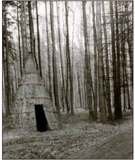
Rindenhütte „Zuckerhut“ diente als Unterstand im Heiligenwald für Waldarbeiter vom Staatswald errichtet.
