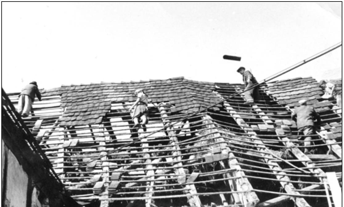
Abriss alte Scheune Hebeiß. Leiter mit Brett dient als Ziegelrutsche für die erhaltenswerten Ziegel. Onkel Karl aus Böckingen, Erna Ulbricht und Pöschls Opa haben geholfen.
