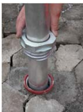
Bodenhülse in Pflaster
