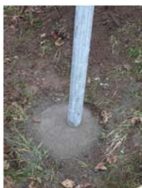
Betonfundament in Erdreich
