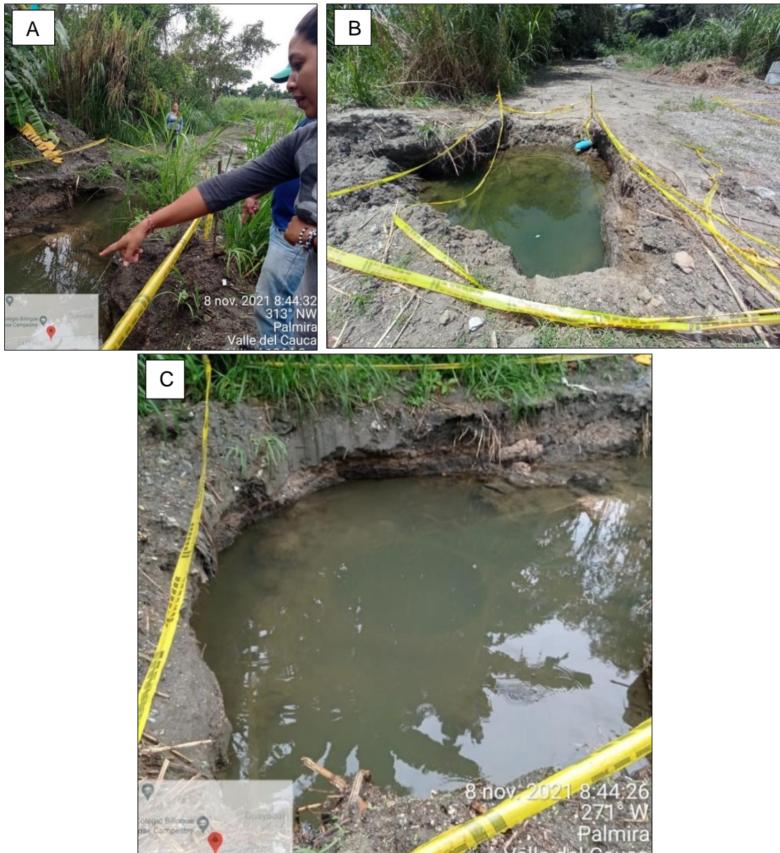
Figura 28. Zanjas de colector sanitario Ptar, predio al lado derecho del Sector de Los Roa Las imágenes A y C, son en la actualidad las franjas del colector sanitario para la PTAR. La imagen B, corresponde a una de las zanjas de las tuberías tomadas por un funcionario de la DGRD en la visita del 4 de octubre del 2021. Fuente: elaboración propia.
