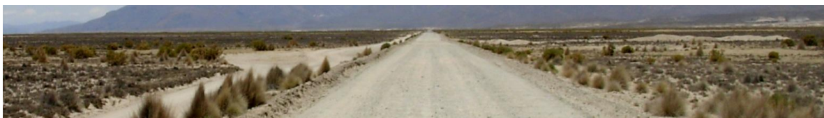
Vista de la carretera que comunica Uyuni con Pampa Aullagas
