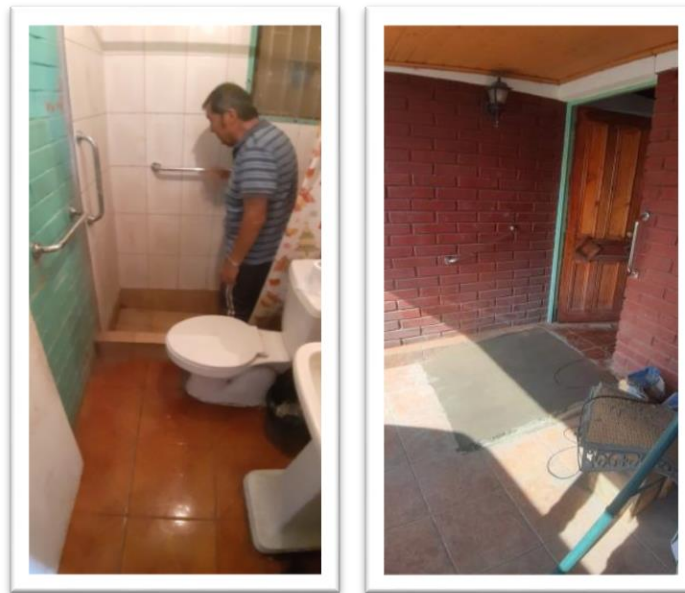
Fotografías 16 y 17 “Instalación de barras de Seguridad y Construcción de Rampa”
