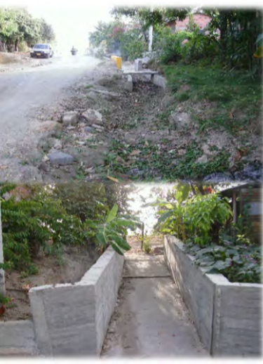
Canaleta aguas lluvias sector calceta de las Vargas (Vereda Tarqui)
