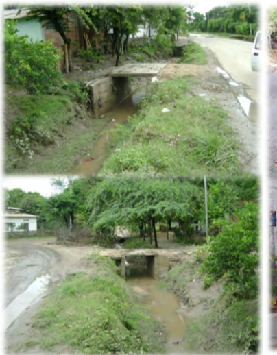
Construcción de pontones en concreto en la Vereda Topacio
