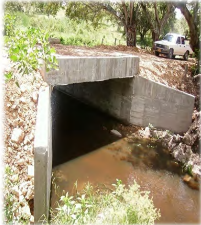
Construcción de obras de arte en vías terciarias rurales por valor de $120 millones de pesos.
