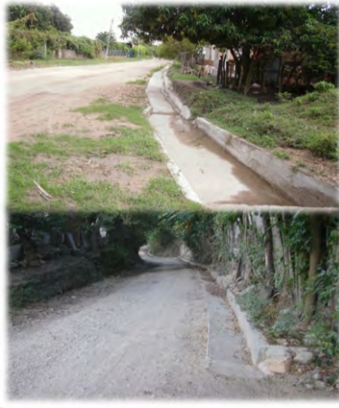
Cunetas en concreto sector Topacio y Crucetal
