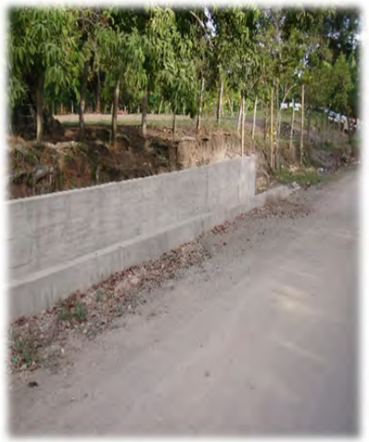
Canaleta en concreto en el sector de la vereda Camalá
