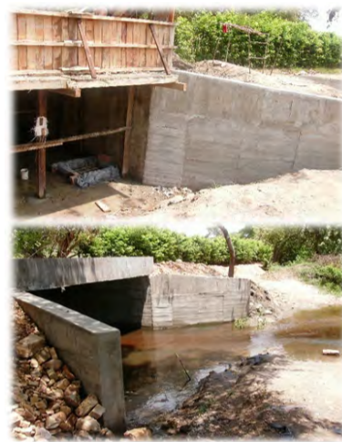
Construcción de un box coulvert entre la vereda colegio y Paraíso (quebrada calabozo)
