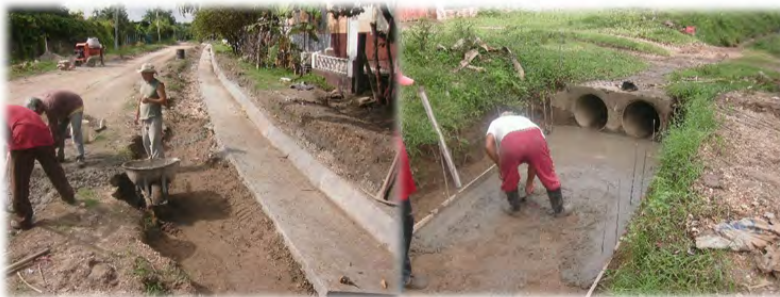
Construcción de canaletas de aguas lluvias en la vereda Paradero I
