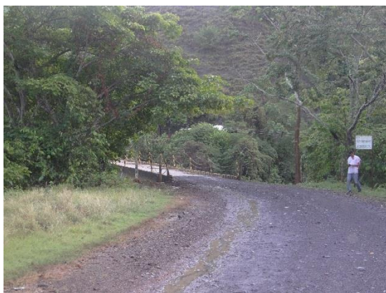
a) Vía sitio puente quebrada la cristalina
