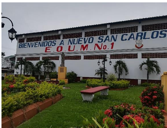
Entrada a la Cabecera Municipal, Nuevo San Carlos, Retalhuleu
