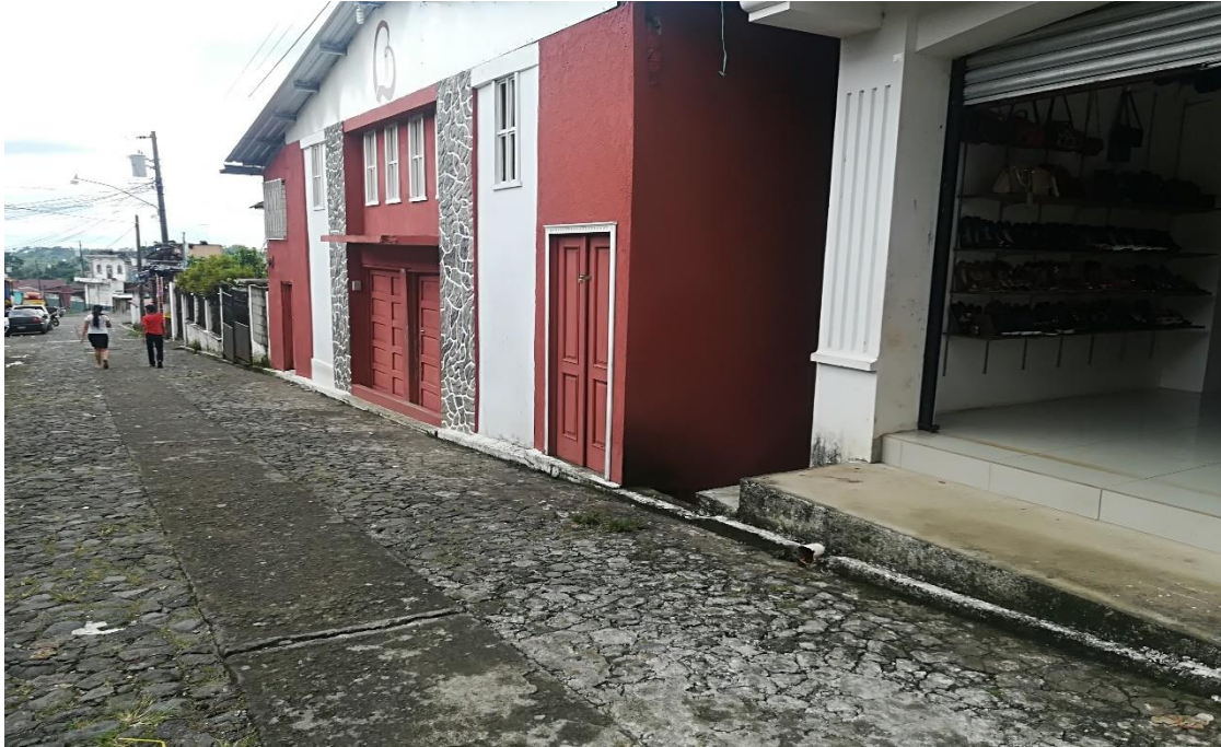
Invasión de línea de fachada de viviendas en Candelaria Xolhuitz, Invasión carretera municipal según Reglamento sobre derecho de vía de los caminos públicos y su relación con los predios que lo atraviesan, quince metros; y, 7.50 Metros Cada Lado.
