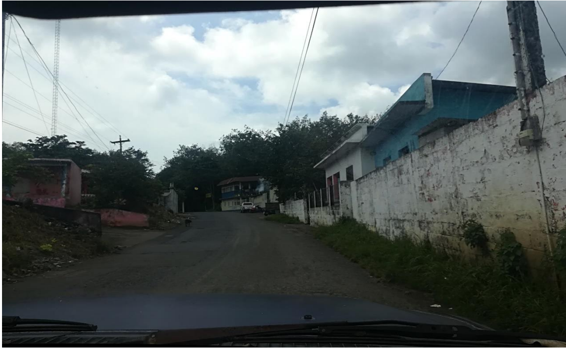
No existen banquetas en Aldea la Libertad, Nuevo San Carlos, Retalhuleu, los peatones corren riesgo al caminar por la carretera, hay espacio para construir banquetas.
