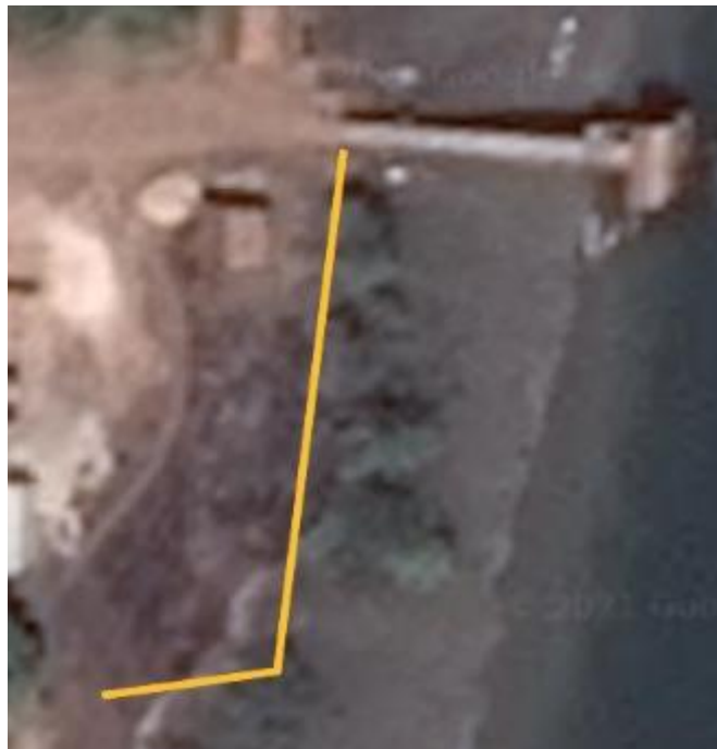
Figura 01: Vista do satélite a área com deterioração por ação da maré.
