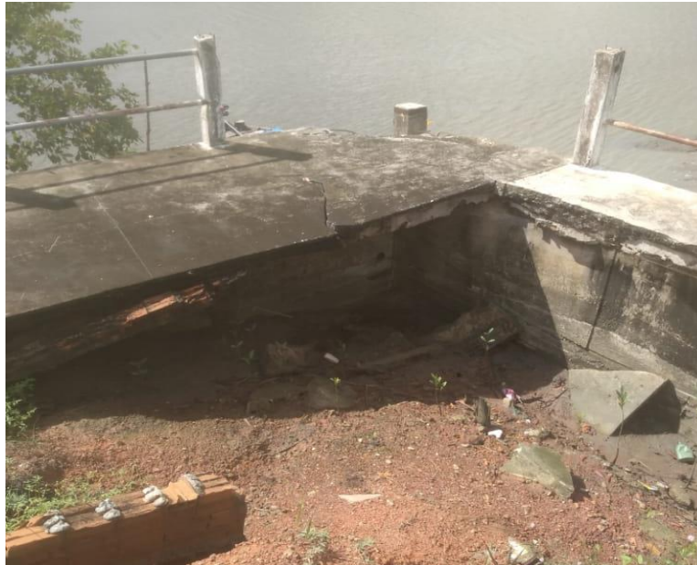
Foto 09: Erosão do solo bastante avançada, tendo perda total da calçada, urbanização e aterros compactados das áreas próximas.
