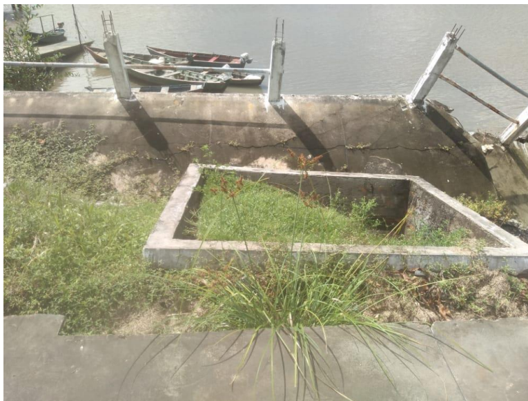
Foto 07: Rebaixo do nível da calçada e queda da área destinada ao plantio de palmeira, causada por deterioração do solo e rompimento da contenção.
