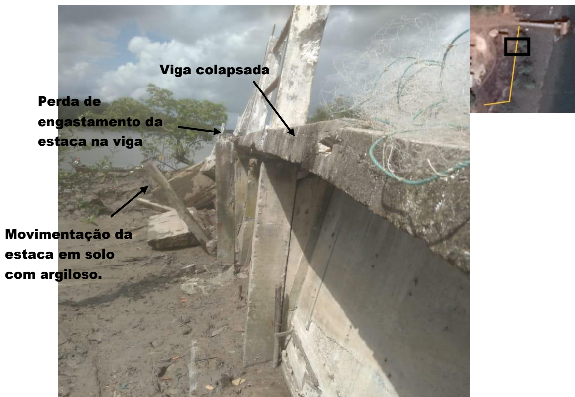
Foto 02: Vista em perfil das estaca sendo empurradas pelo solo da área de urbanização.
