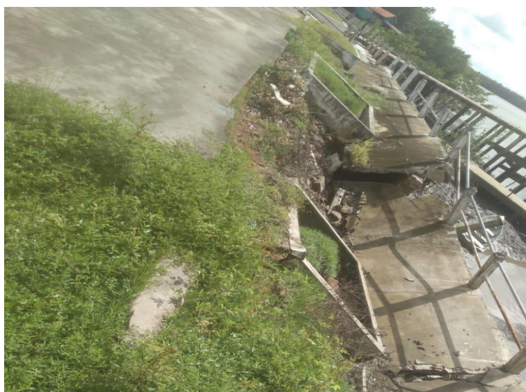
Foto 08: Colapso total da estrutura da calçada.
