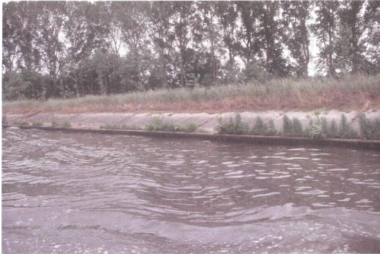
Foto 16. Oevers verdedigd door kopbalken en schuine betonplanten te Oudenaarde, laten geen noemenswaardige vegetatieontwikkeling toe.
