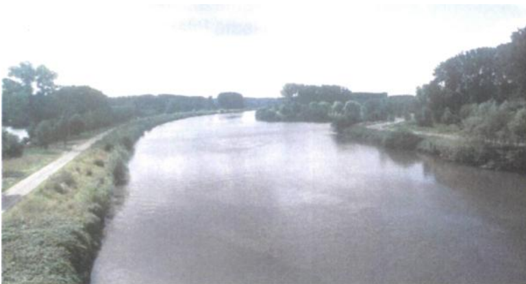
Foto 5. Stroomopwaartszicht op de Bovenschelde ter hoogte van de Brug te Eine (Oudenaarde); het streefpeil van dit pand bedraagt 8,27 m TAW.
