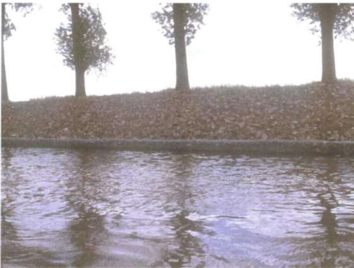
Foto 20. De nieuwe oeververdediging bestaat uit schanskorven ter hoogte van de waterlijn en steenbestorting op het talud, waarbij het talud tevens een steilere helling kreeg. Hierdoor verminderen de mogelijkheden voor de vestiging van oeverplanten aanzienlijk.
