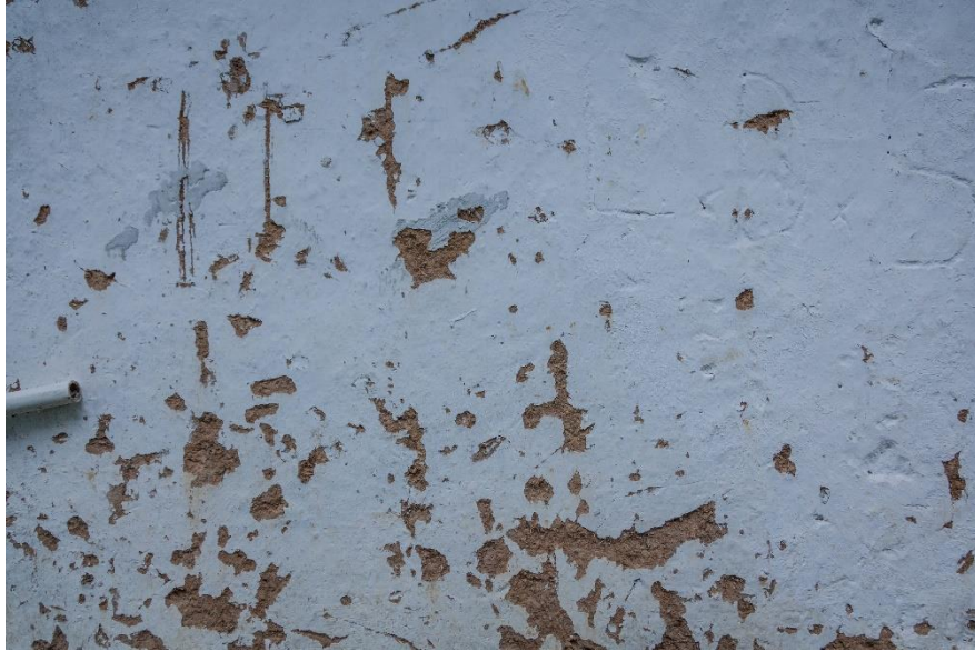
Muro de tapia empañetado y cubierto de cal. Fotografía Jorge Cano. Árbol Visual, 2018.
