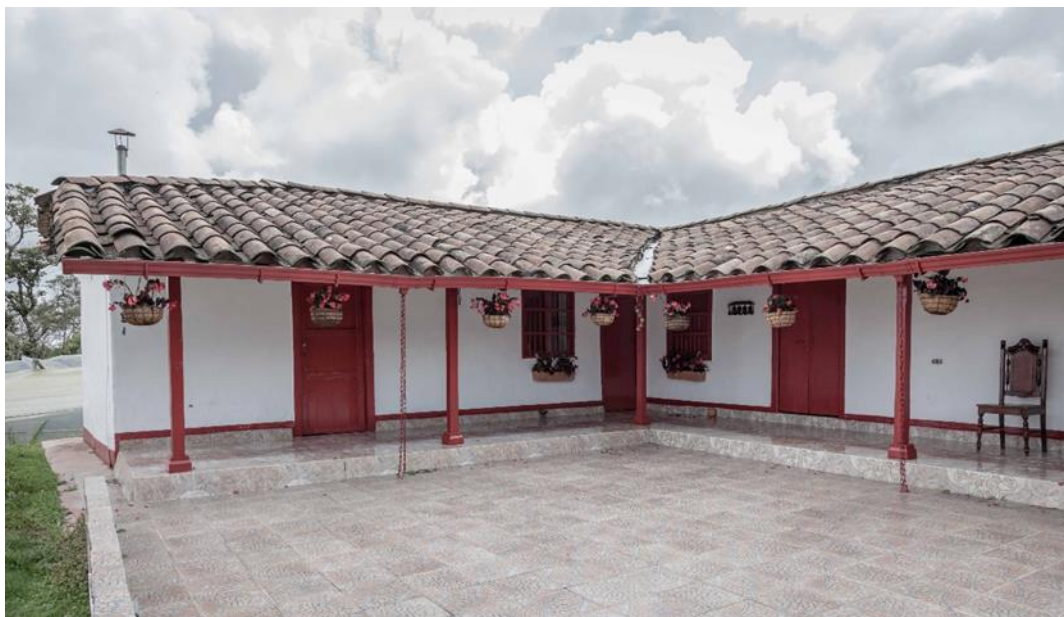
Fachada de una vivienda de tapia con volumetría en L o de número , cubierta de teja a dos aguas. Veredas La Palma. Fotografía Jorge Cano. Árbol Visual, 2019.
