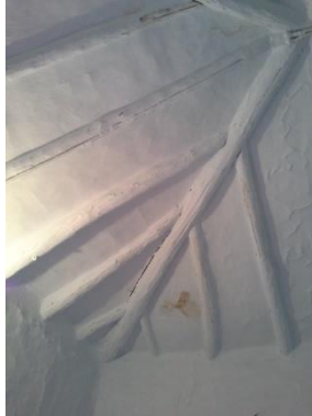
Estructuras de la cubierta o techo de viviendas tradicionales construidas en tapia. Fotografías María Teresa Arcila, 2018
