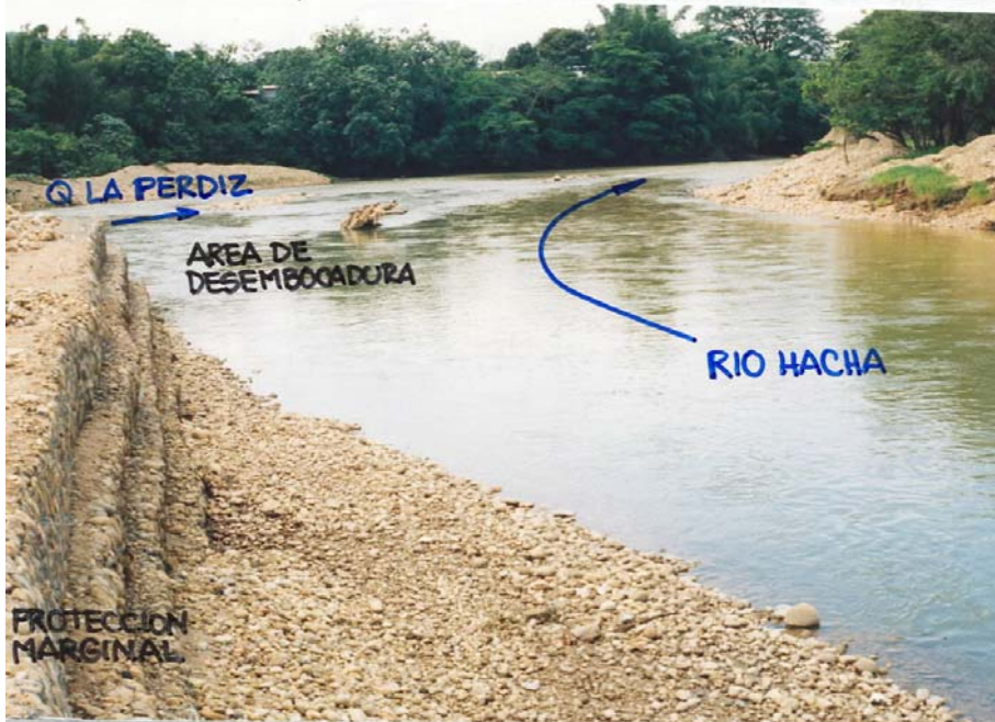
SITIO 1. Vista de detalle hacia aguas abajo de la confluencia del Río Hacha con la Quebrada La Perdiz. Obsérvese el muro en gaviones construido como protección marginal contra inundaciones sobre la margen izquierda del Río Hacha (altura 4 m aprox). La margen derecha es susceptible a inundaciones durante las crecidas del río y la quebrada La Perdiz.
