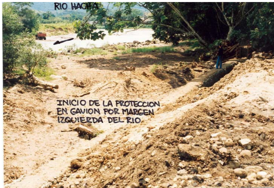
SITIO 1. Vista de detalle sitio orilla izquierda Río Hacha aguas arriba de la desembocadura de las quebradas El Dedo y la Yuca. Obsérvese el estado de avance del muro en gaviones para protección contra las crecidas (en construcción).
