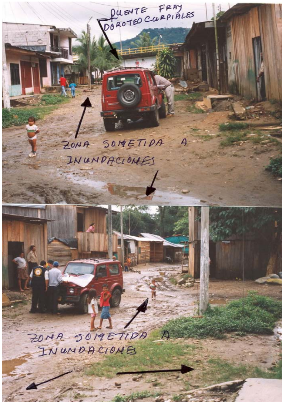
SITIO 3. Sector aguas abajo del puente Fray Doroteo Curpiales sobre la Quebrada La Perdiz (margen derecha), sometido a frecuentes inundaciones durante las crecidas de las quebradas La Perdiz y La Sardina. En el evento del 14 de junio de 2003 falleció una menor ahogada por el elevado nivel de las aguas y haber quedado atrapada en su vivienda.
