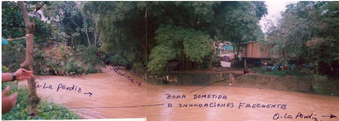
SITIO 4. Vista sector de confluencia de las Quebradas La Perdiz y La Sardina. Obsérvese la susceptibilidad de la zona ante los fenómenos de inundaciones y socavamiento lateral en sus orillas.
