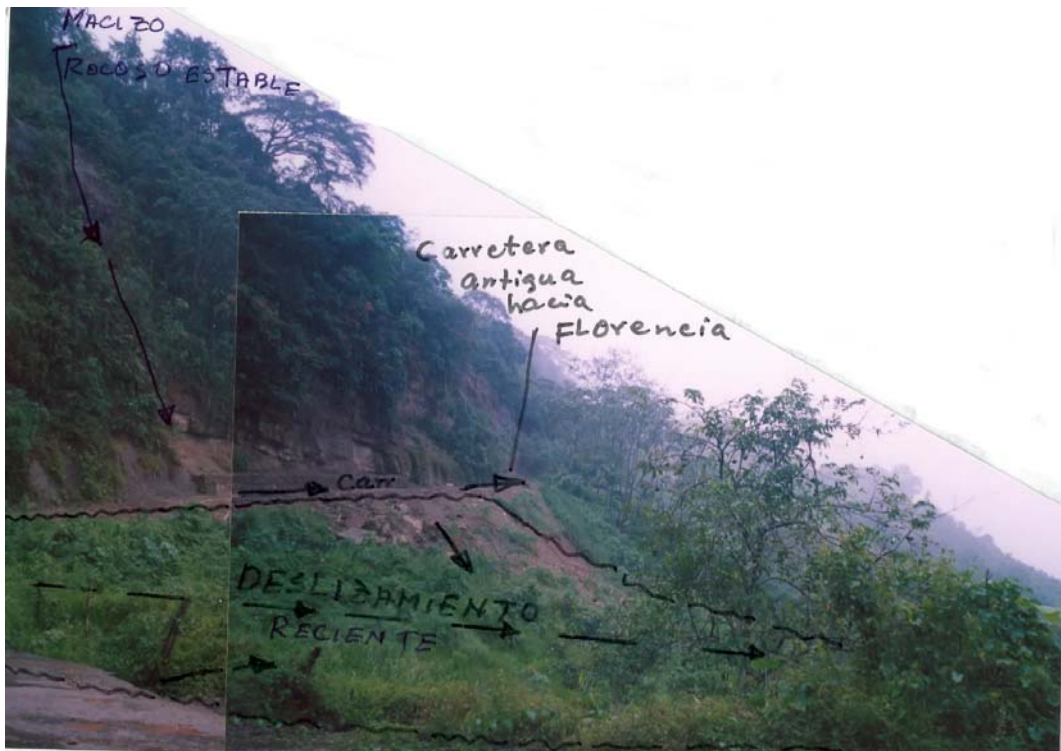
SITIO 7. Vista sector de deslizamiento reciente en el talud inferior de la carretera antigua hacia Florencia, parte posterior de los tanques de aprovisionamiento del acueducto de Florencia, frente a la planta trituradora de materiales CONOCOM..
