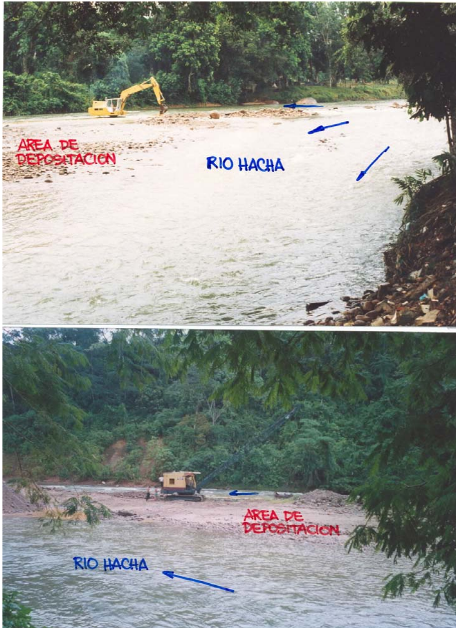
SITIO 9. Río Hacha al suroeste del Batallón, en el Barrio La Vega. Obsérvese el desarrollo de obras de dragado para direccionamiento del canal principal del río hacia la margen derecha, opuesta a la ubicación del barrio.
