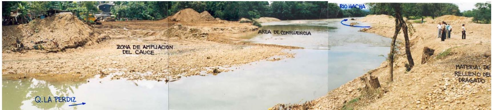
SITIO 1. Vista panorámica y de detalle del sitio aguas arriba de la desembocadura de la Quebrada La Perdiz en el Río Hacha. Obsérvese el desarrollo de las obras de protección y dragado realizadas en esta área de confluencia. Nótese además el material de dragado dispuesto como relleno en la margen derecha de la Quebrada La Perdiz, y el apilado sobre la margen derecha del Río Hacha y la margen izquierda en el área de confluencia.
