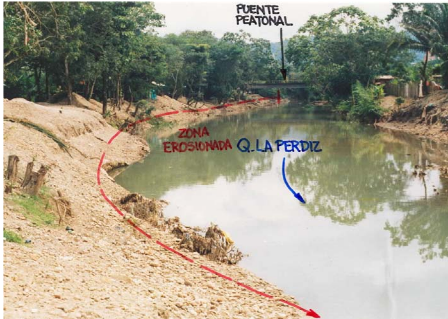
SITIO 2. Vista panorámica desde aguas abajo del puente peatonal Juan XXIII sobre la Quebrada La Perdiz. Obsérvese los efectos de la crecida de la quebrada el 14 de junio de 2003.
