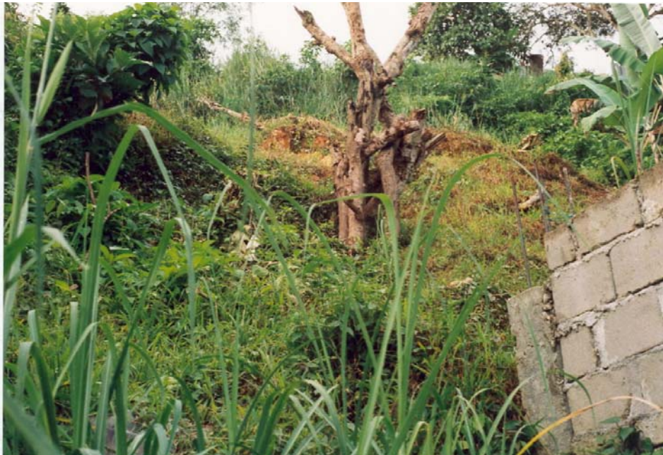
SITIO 12. Vista de detalle del sitio afectado en el Barrio Villa Mónica, afectado por deslizamientos. Obsérvese en la parte alta y baja del talud viviendas afectadas por los procesos de inestabilidad.
