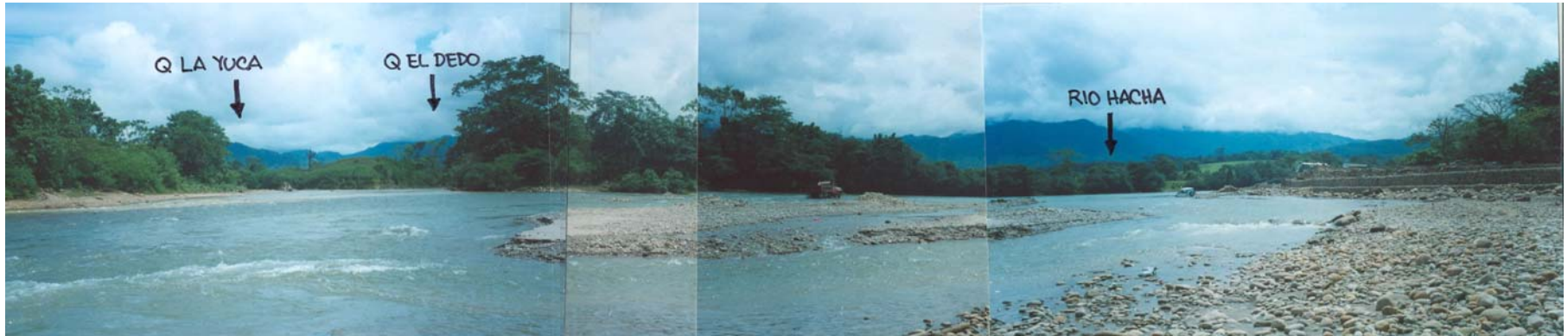
SITIO 1. Vista panorámica y de detalle del sector de desembocadura de las Quebradas La Yuca y El Dedo (margen derecha) al Río Hacha (Sector la Bocaiva). Obsérvese a la derecha en la fotografía, el muro en gaviones para protección contra inundaciones ubicado sobre la margen izquierda, y la explotación de materiales del lecho del río realizada en este sector.
