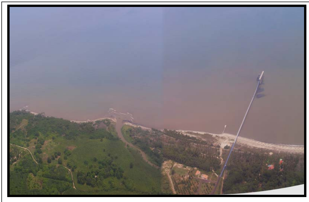
Figura 7. Muelle adjunto al Río Córdoba y a perfiles 158 y 159.
