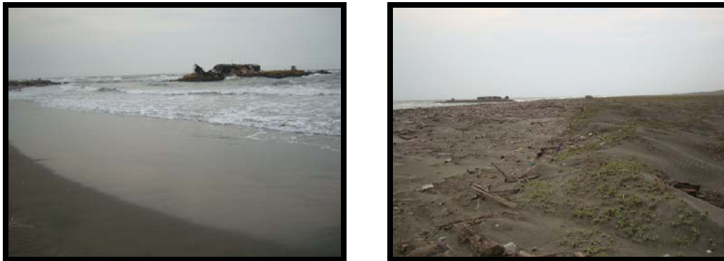
Figura 11. Espolón destruido parcialmente, visto en direcciones EW y WE en inmediaciones de los perfiles 114 y 113 Parque Isla de Salamanca (ver base de datos anexa).
