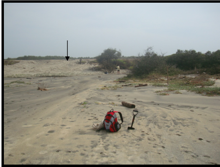
Figura 10. Terraplén de la vía Santa Marta-Barranquilla en inmediaciones del perfil 132 (ver base de datos anexa).
