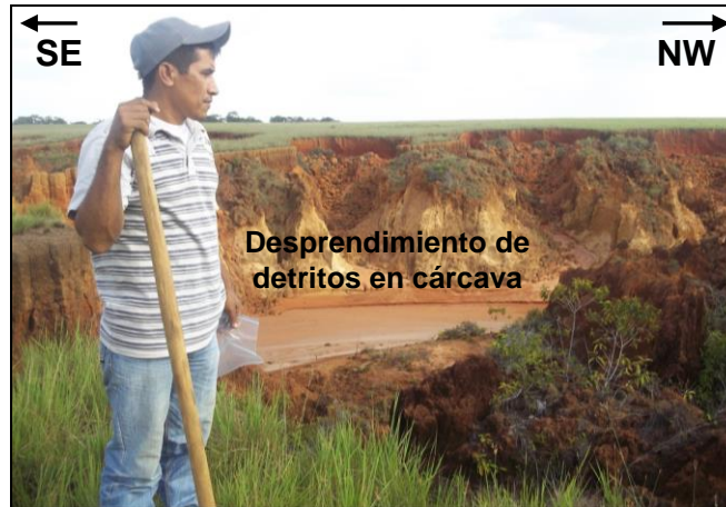
Figura 55. Procesos erosivos y formación de flujos de detritos en cárcava por erosión. se observa arenas friables de cuarzo, no consolidadas. Estación OM-010. Coordenadas N: 997,888; E: 1,167,785; Cota 143 m.s.n.m. Azimut 170°.
