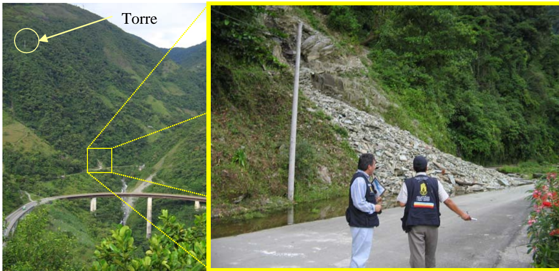
Figura 9. Aspecto de la parte media y baja de la quebrada Chirajara. Nótese el cono de flujo de detritos formado en el sector de la escuela Chirajara Baja e igualmente el deslizamiento translacional tipo avalancha de detritos en el margen izquierdo de la quebrada
