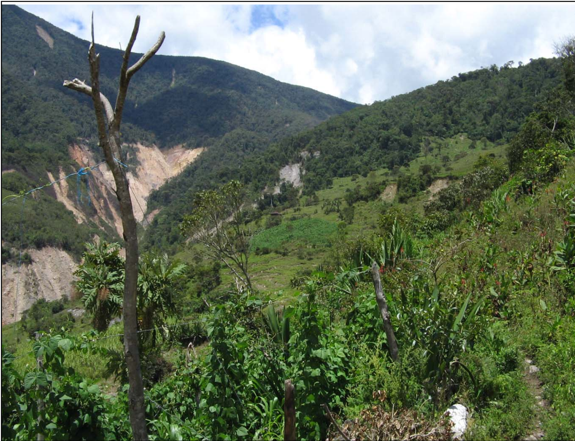
Figura 20. Aspectos del deslizamiento rotacional del margen izquierdo de la quebrada El Cobre. Nótese los escarpes de deslizamiento secundarios en la parte centro derecha que evidencian la reactivación del fenómeno y las cicatrices de avalanchas de detritos presentes en el margen derecho de la quebrada (izquierda de la fotografía).
