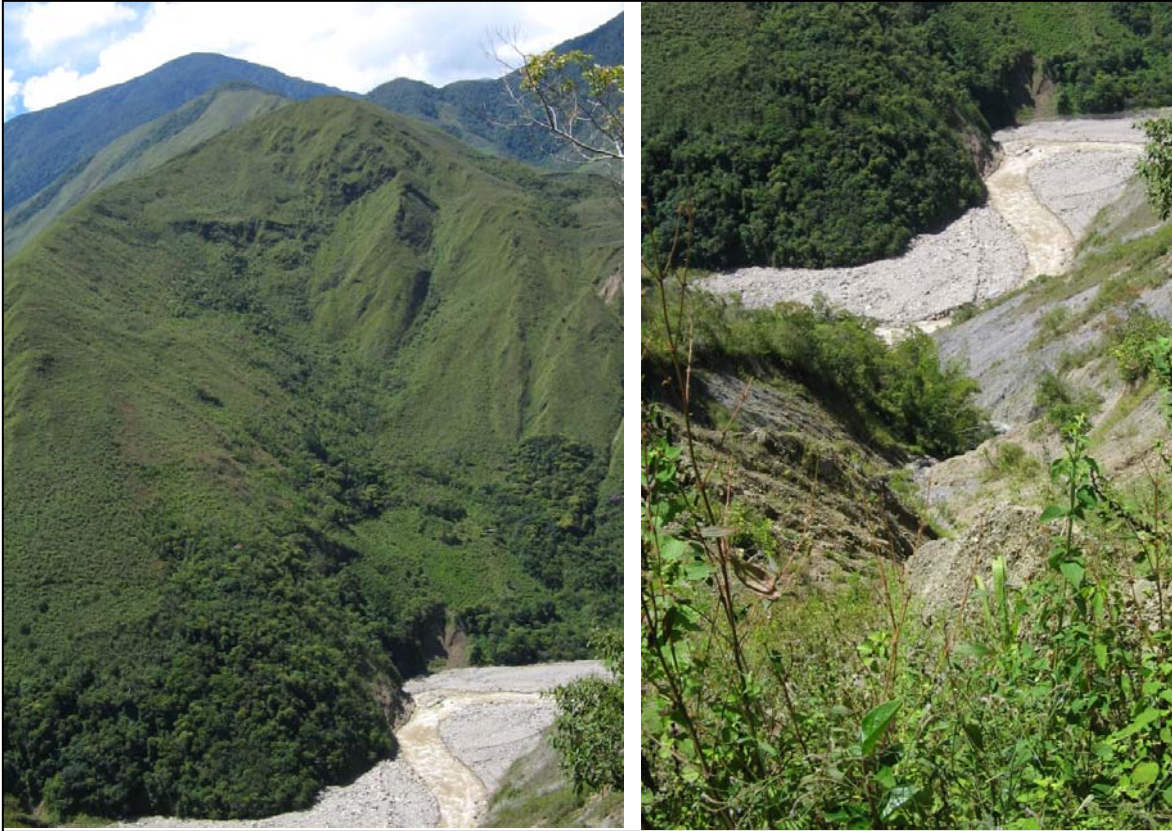
Figura 18. Mecanismo de falla en el sector de Tunque. Nótese el movimiento en masa frente al sector visitado (margen derecha) y la acción del río Blanco en la pata del talud. A la derecha se observa la base del área inestable de Tunque (margen izquierda).
