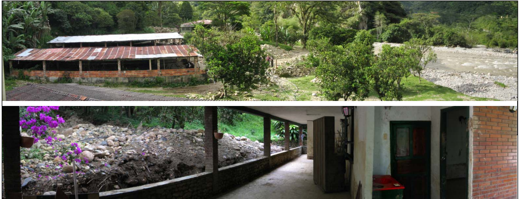
FIGURA 23. Panorámica de la confluencia de la quebrada El Aguardiente en el río Blanco. Arriba nótese en la parte trasera el cono de deyección de escombros que invadió la vivienda del señor Jairo Martínez y abajo detalle del estado del cono y la vivienda una vez removidos los escombros.
