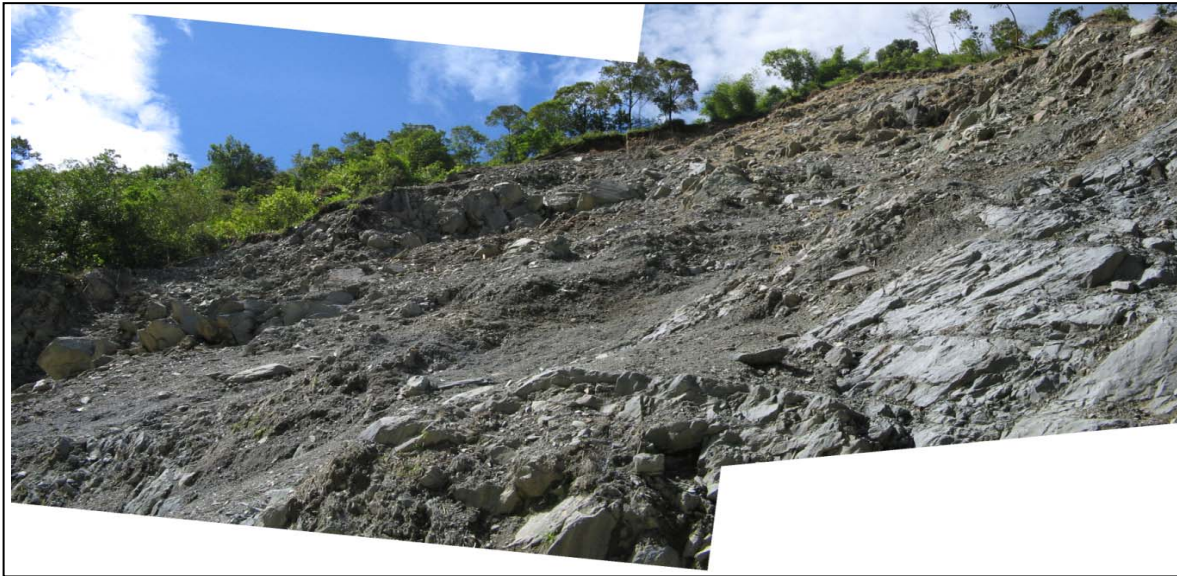
Figura 7. Aspecto de la cicatriz de deslizamiento del Km 64 + 800 durante la visita del 20 de octubre de 2005. Nótese los planos de deslizamiento a favor de la pendiente y el alto fracturamiento de las rocas.
