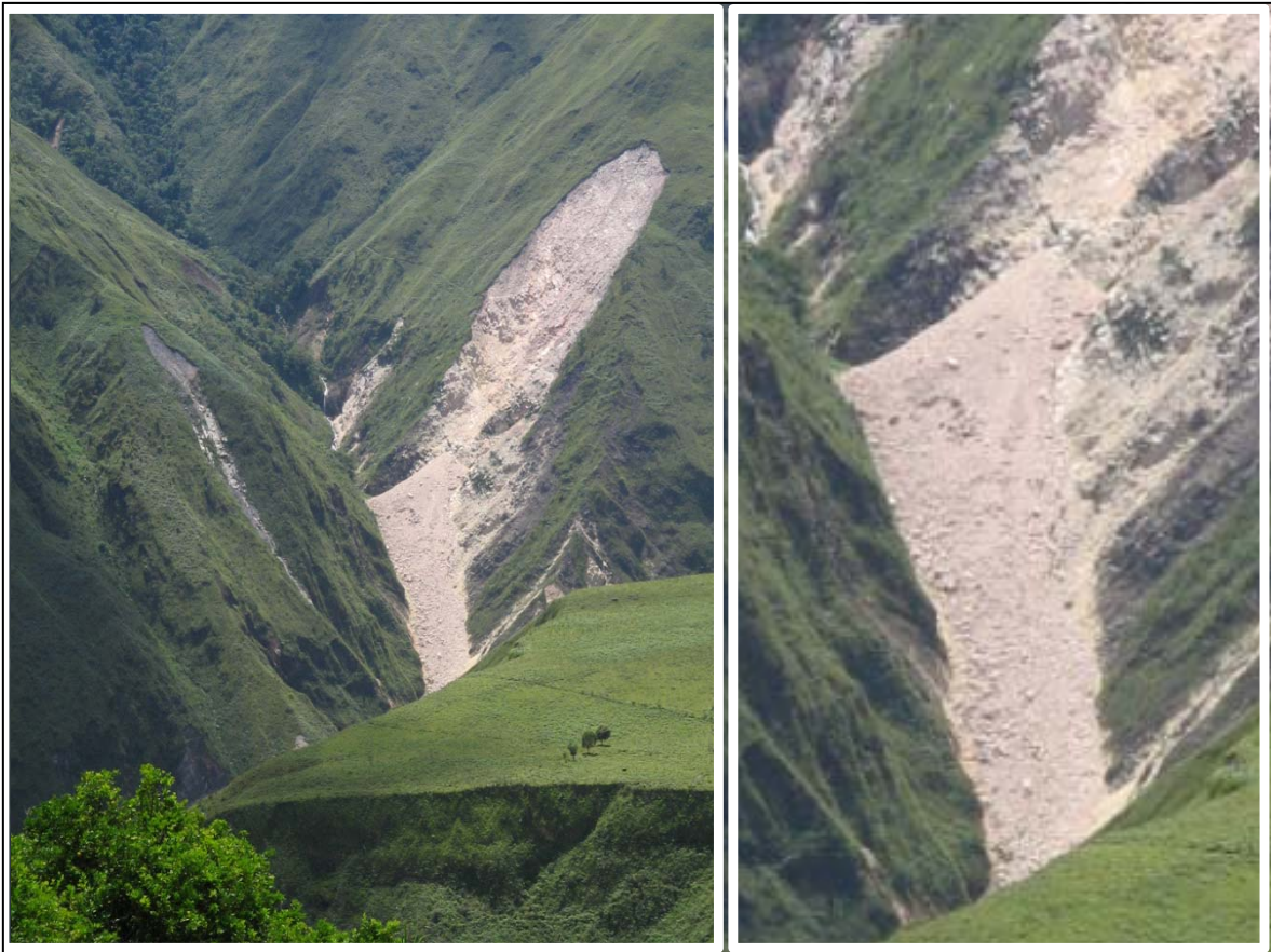
Figura 21. Aspecto de detalle de los deslizamientos tipo avalancha de detritos típicos de la región de Guayabetal Sector Vereda El Espinal. Nótese la obstrucción de la corriente que puede posteriormente generar flujos e inundación de detritos.
