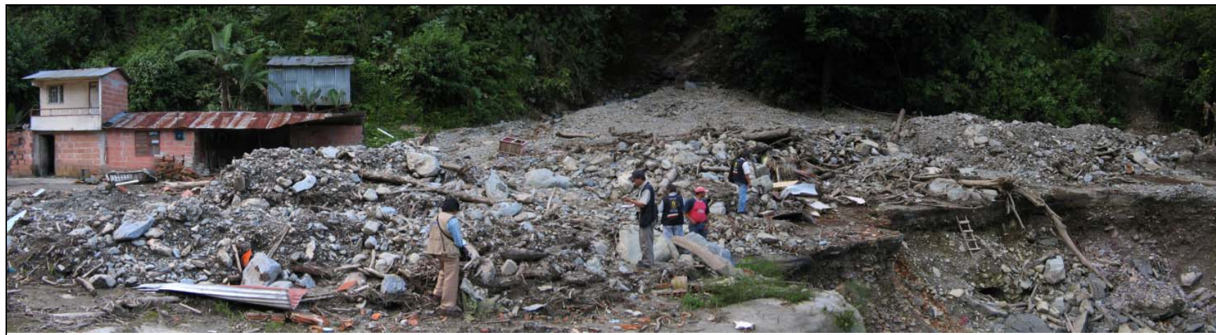
Figura 12. Aspectos del cono formado por los flujos de escombros o detritos en el sector de Chigüire. Nótese el tamaño de los sedimentos mas gruesos hacia la parte distal y los daños ocasionados en las viviendas del lugar. Al fondo se observa el cauce de la quebrada cuyo lecho está constituido por roca y que quedó prácticamente limpio.
