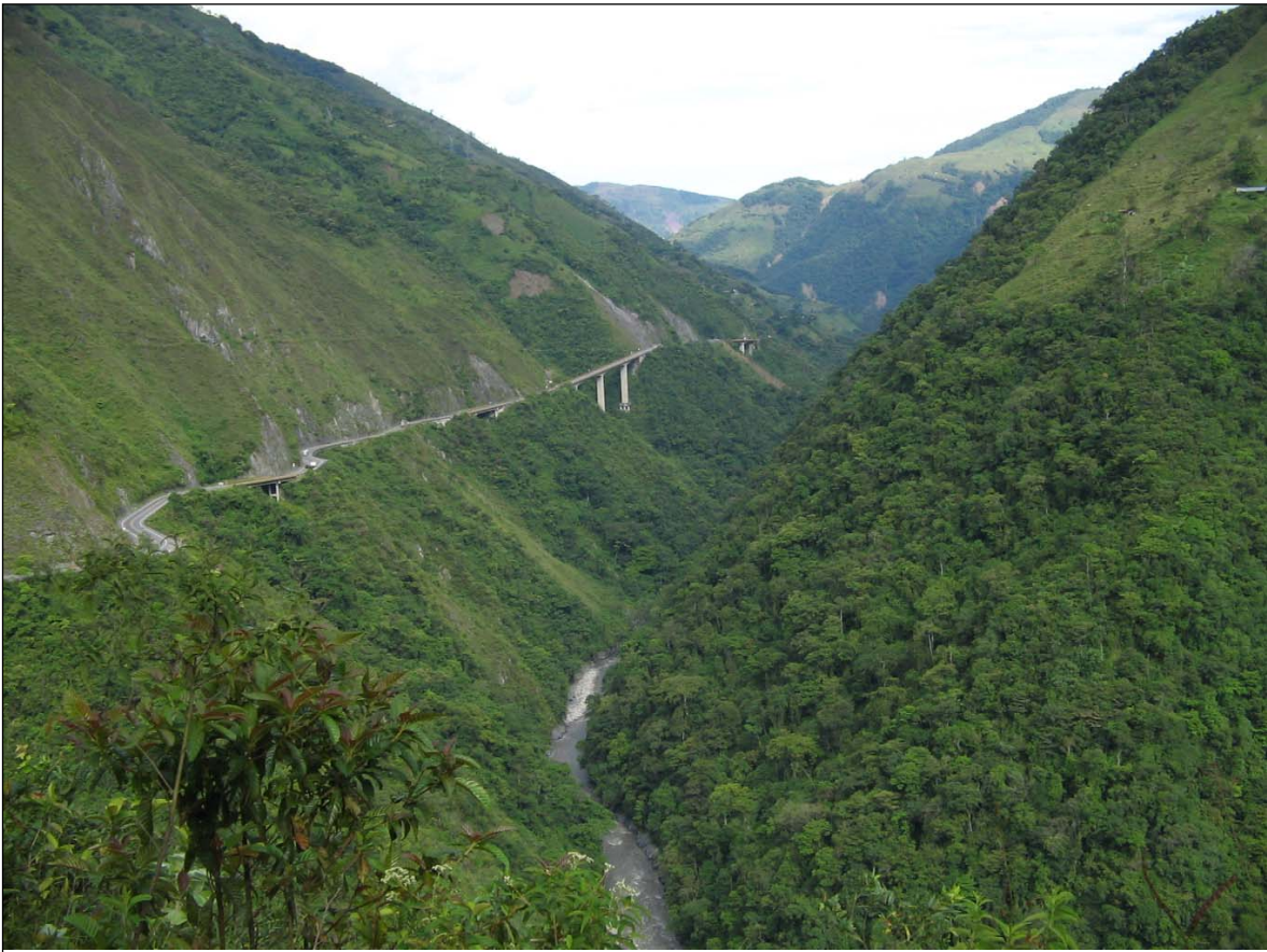
Figura 11. Vista hacia el oriente de la faceta triangular que determina las características geomorfológicas de la loma Chirajara por el sur. Nótese las cicatrices deslizamientos tipo translacional (flujos de roca y detritos), definidos a la altura de la carretera hacia Villavicencio en el km 64 + 200.
