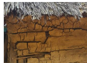
Ilust. 59. Muro en Bahareque. Fotografía. Brayán Flórez R
