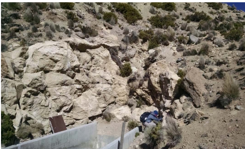
Fotografía 5.8 Afloramiento de la Formación Sencca a la salida del túnel de descarga de la represa Paucarani, también se encuentra en la base del embalse, lo que propicia el represamiento del agua.
