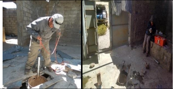
36X – AGT – 054: Pozo PA- 3, ubicado cerca al caserío de Ancuyo, actualmente no cuenta con equipamiento de bombeo.
