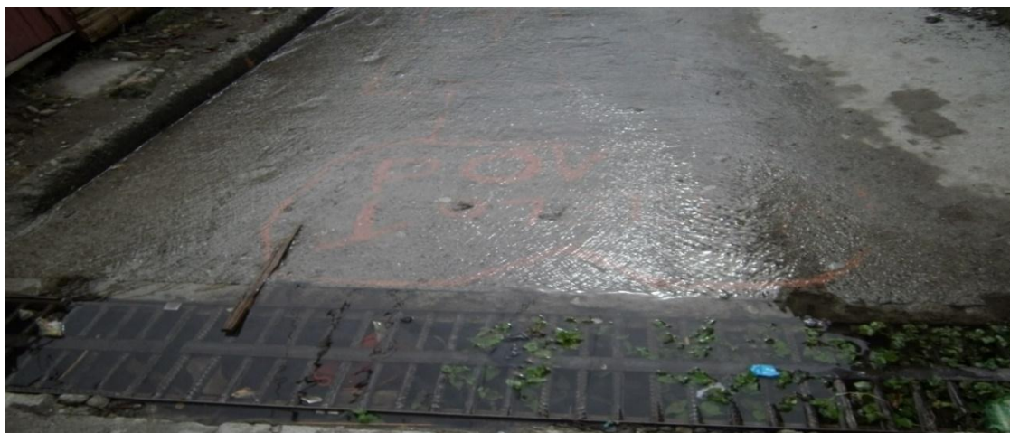
Imagen 13. Registro fotográfico del barrio Santa Ana. Fuente: ing. ambiental Alcaldía Municipal del municipio de Villamaria Caldas. Departamento Gestión del riesgo oficina de Planeación.
