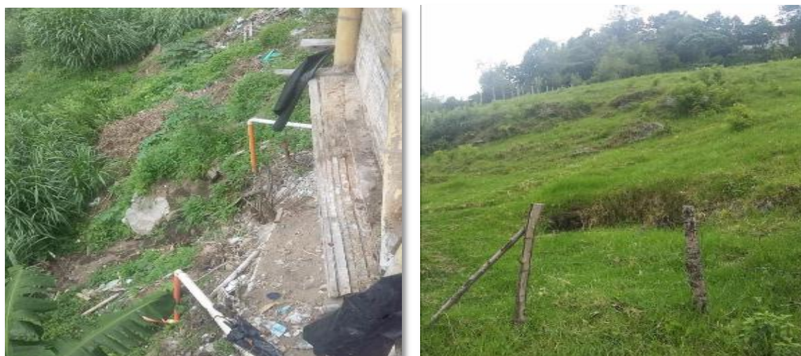
Imagen 18. Vertimientos de aguas servidas directamente a la ladera, cicatrices de pequeños deslizamientos en el barrio. Zona de estudio ubicada en la antigua vía Férrea – municipio de Villamaría, Caldas. (2016) Fuente: Elaboración estudiantes Especialización en Prevención, Atención y Reducción de Desastres UCM.
