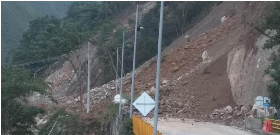
Figura 21. Deslizamientos sobre ambas calzadas vía Bogotá – Villavicencio Fuente: Coviandes S.A.S año
