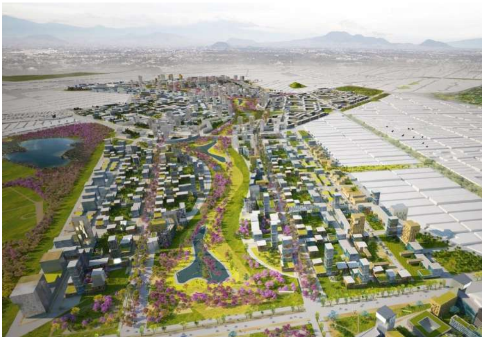
Figura 344 Nuevo Aeropuerto Internacional Ciudad de México
