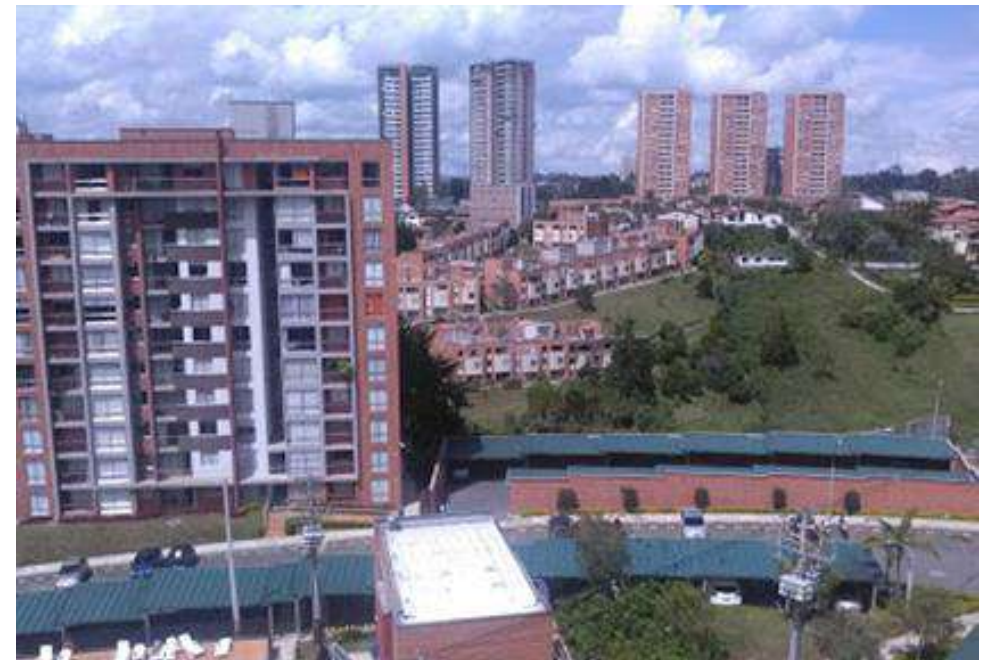
Figura 260 Torres del Campo actualmente con vacíos a consolidar
