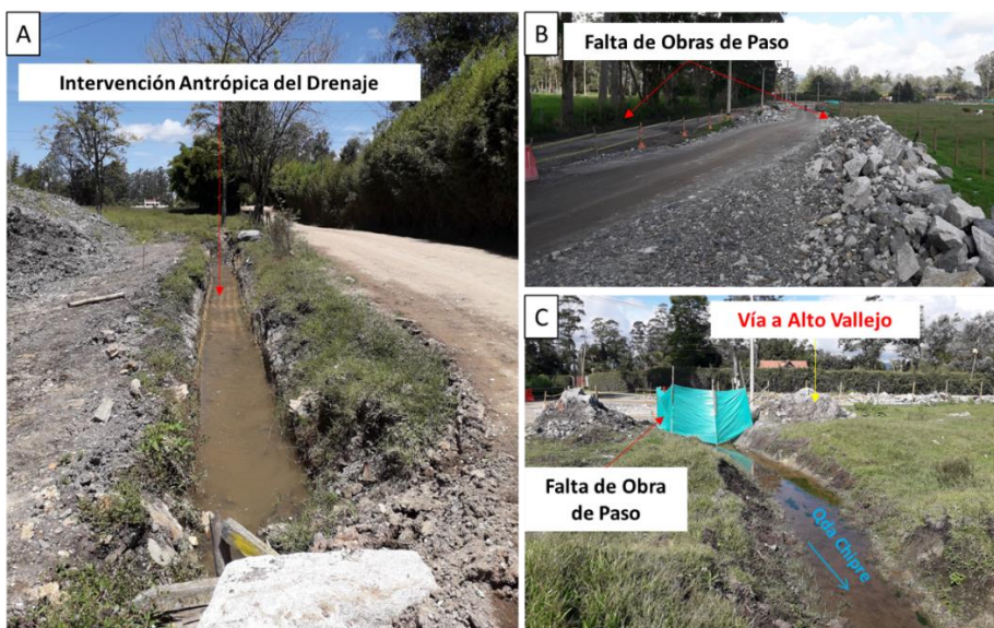
Ilustración 98. Condición de amenaza y riesgo por socavación e inundación en Drenajes Chipre para actores privados y municipio.
