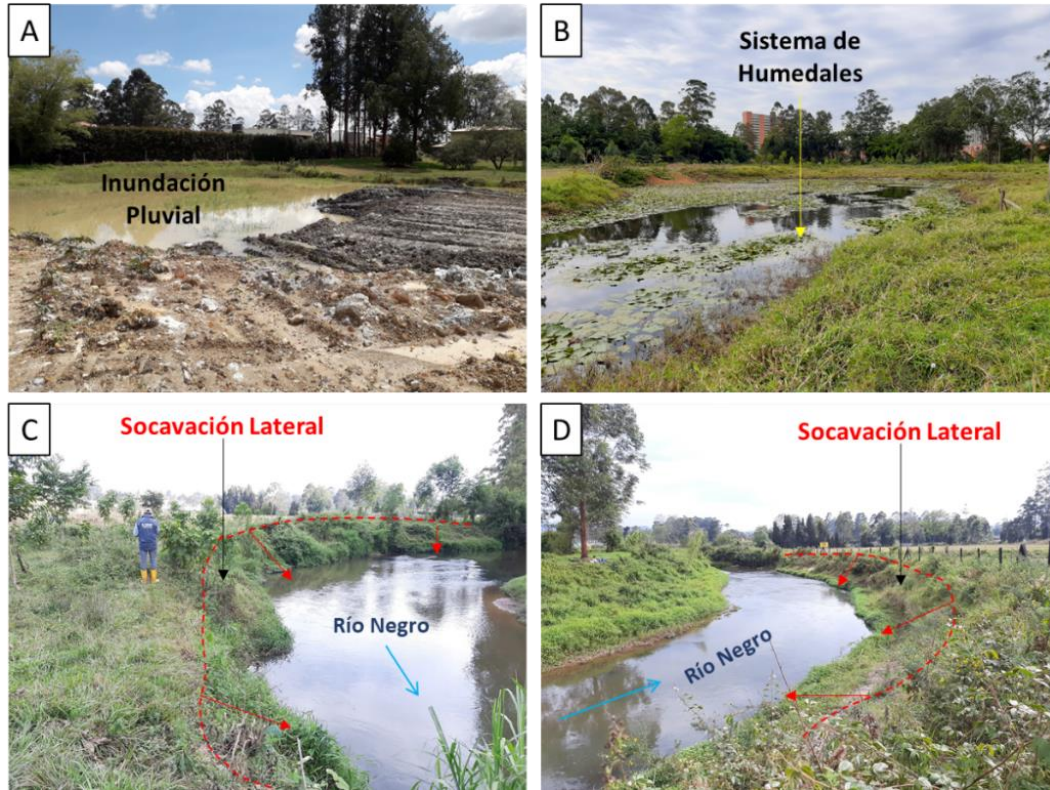
Ilustración 94. Áreas con condición de amenaza por socavación e inundación.
