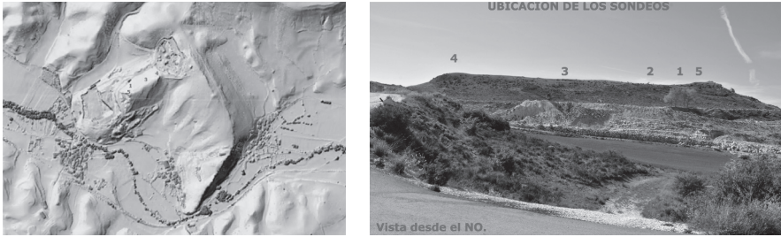
Fig. 4. Castromayor con la ubicación de los sondeos: LiDAR y vista desde el oeste.
