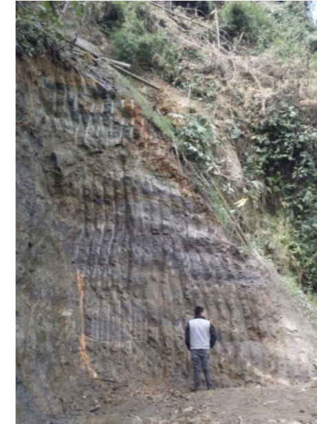
Figura 12. Deslizamiento rotacional suspenso. Portal de salida. (759211E;9951006N).
