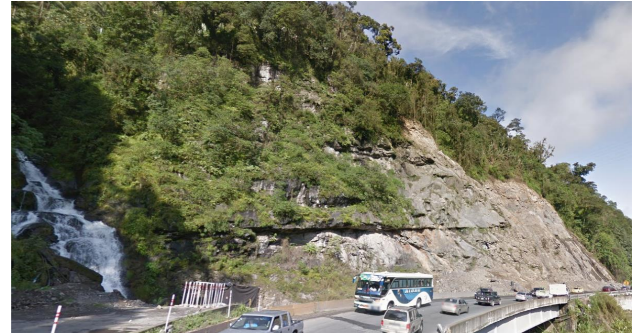
Figura 4. Ejemplo de accidente drenante, así como de la geomorfología de la zona. Fuente: GooleEarth.
