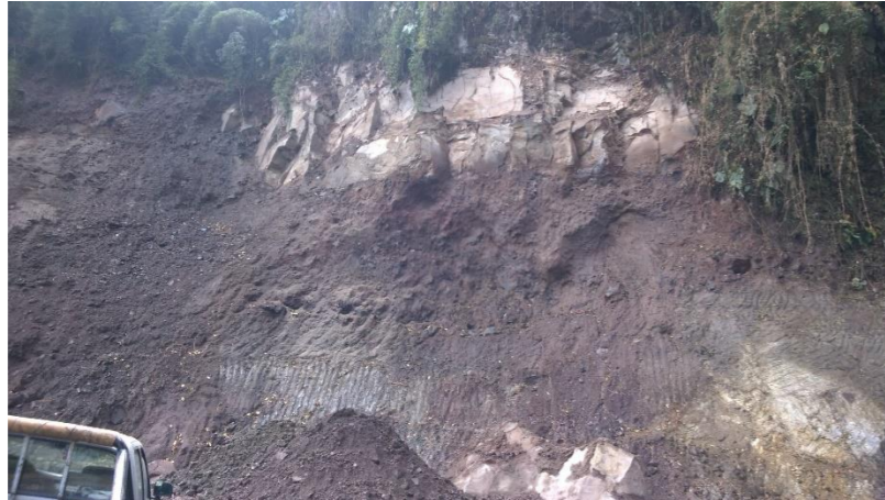
Figura 10. Talud escarpado en lavas andesitas piroxénicas debido a la caída de bloques (757817E;995020N).
