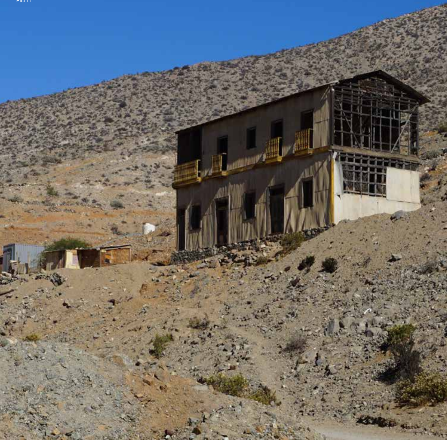
Antigua Escuela de Quebradita Hito 11
