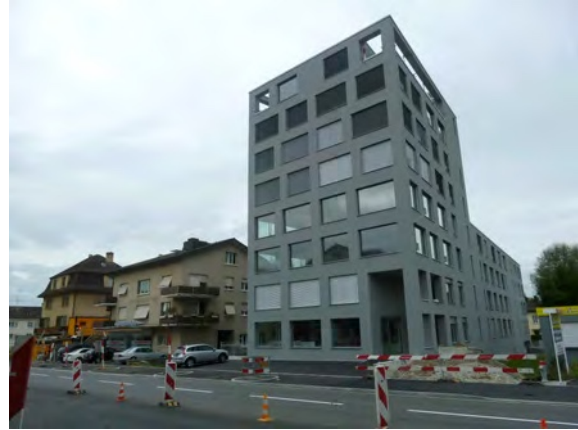
Abb: Wohn- und Geschäftshaus, Schaffhauserstrasse 131 (Foto Planpartner, 2011)
