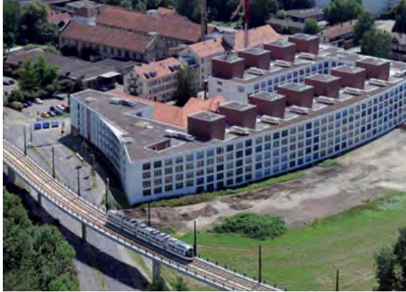
Abb: Zwicky-Areal, Wohn- und Gewerbeüberbauung Zwickystrasse, fertig 2011 (15.98.1; Quelle: ZH, Raumplanungsbericht 2013, 12.02.2014)
