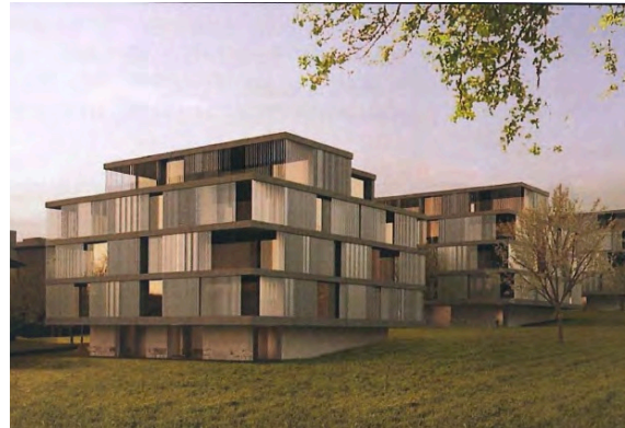
Abb: Wohnüberbauung Casinostrasse, im Bau (Quelle: Visualisierung zur BZO, Entwurf 2013)
