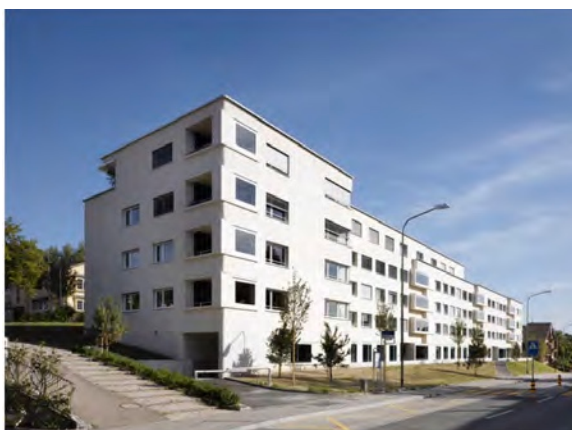
Abb: Bramenring, 1. und 2. Etappe; fertig 2009 und 2011 (10.224; Quelle: Baugenossenschaft Schönheim, Homepage, 2013)
