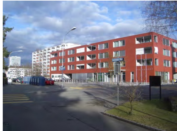
Abb: Stefanshof (Nr. 4.12): Wohnungsbau, fertig 2005 (Foto Planpartner AG, 2008)
