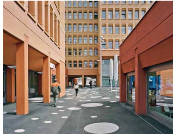
Abb: Zentrumsüberbauung Dorflinde, umfassende Sanierung, fertig 2011 (Nr. 3.134; aus Tec21, Dossier Dorflinde, Foto Georg Aerni)
