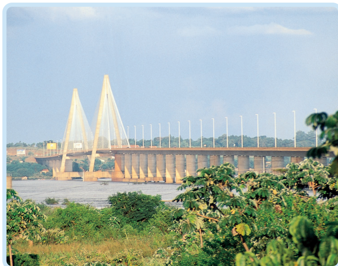
Puente que une las ciudades de Posadas y Encarnación.
