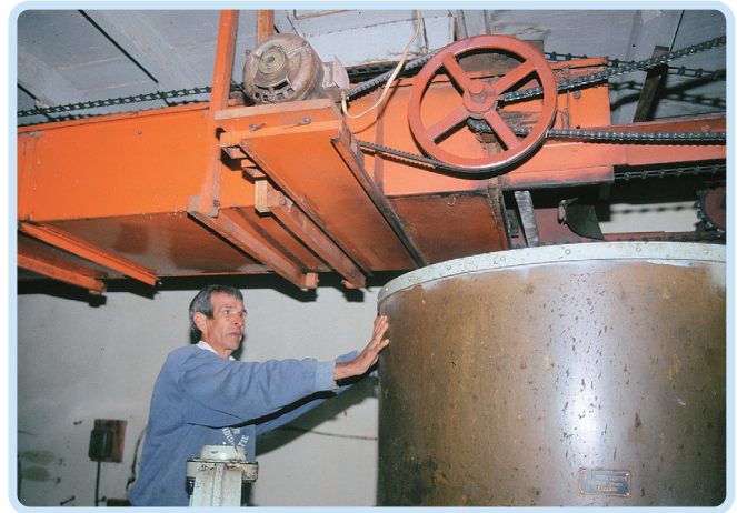
Instalaciones de un secadero.
