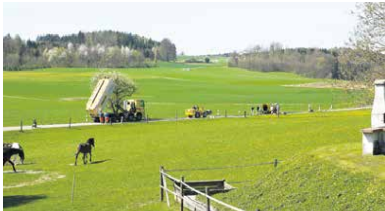
In der ersten Hälfte April wurde das 800 Meter lange Stück auf Nürensdorfer Gemeindegebiet repariert. (Bild: Yvonne Müller)
