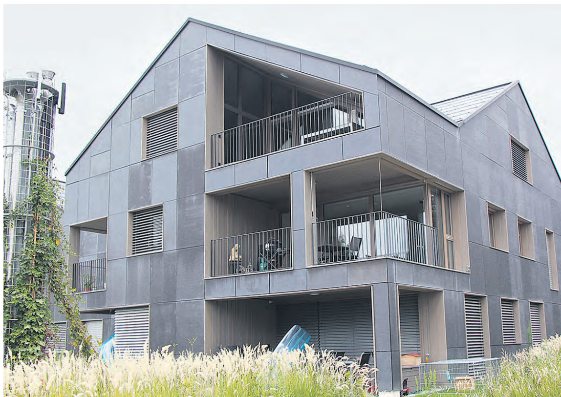
Hier gibt es keine Stromrechnung. Das erste energieautarke Mehrfamilienhaus steht in Brütten. (as)
