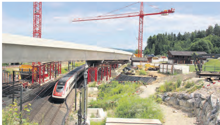
Eine komplexe Baustelle auf einer vielbefahrenen Strecke: die Entflechtung Dorfneft. (tj)
