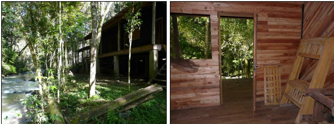
Figuras 112 y 113: Complejo de cuatro habitaciones en margen derecha del Aº del Medio. Vista desde el exterior y detalle del interior de una de las habitaciones. Nótese la instalación de cerraduras, tela mosquera y las camas en el interior. Nótese el arroyo en el exterior. Fotos: Patricio Ramírez Llorens.
