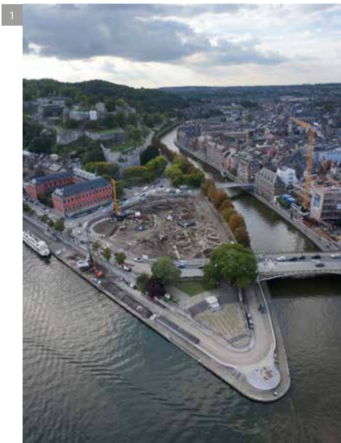
Fig. 1. Le Grognon en travaux : archéologie préventive et construction du parking souterrain, entre Sambre et Meuse (photo : P.-M. Warnier © SPW/DGO4-Dir. Géomatique).
