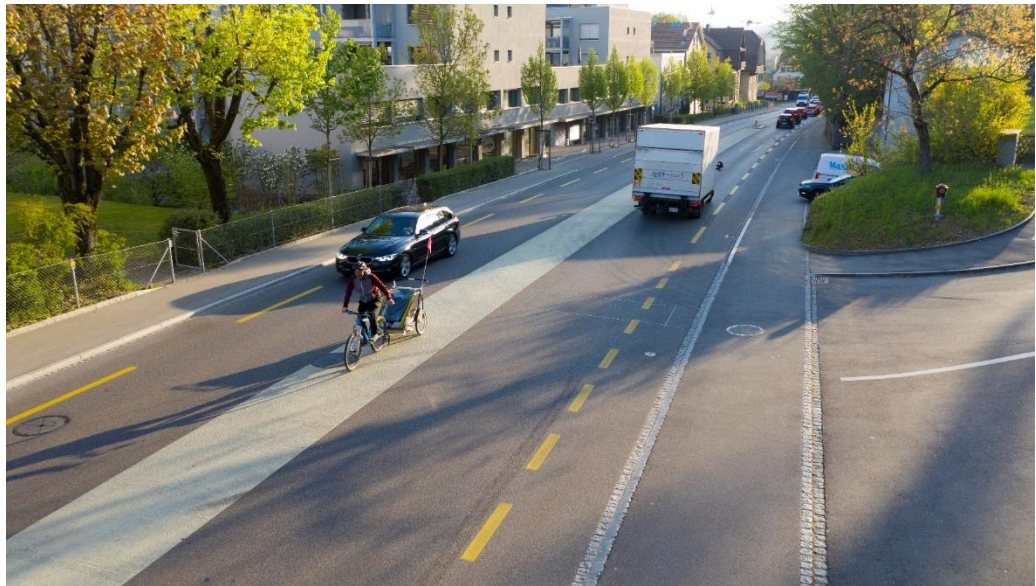
Abbildung 31: Beispielhafte Mittelzone als Abbiegehilfe
