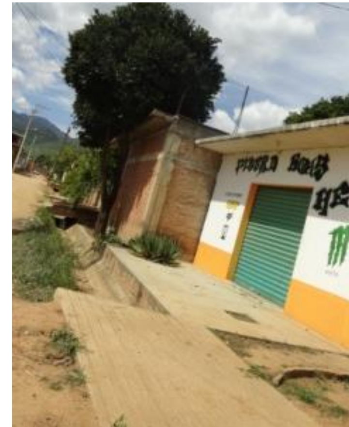
Figura 69. Canal de desagüe en la calle Independencia
