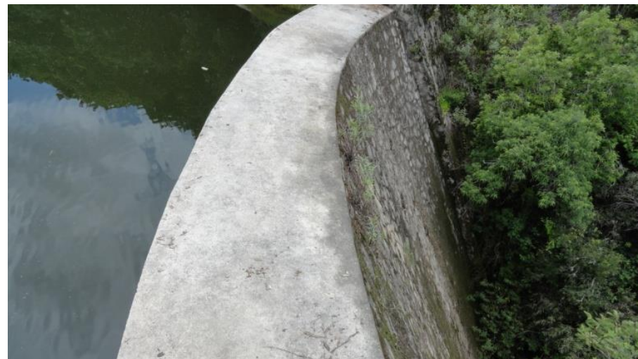
Figura 44. Cortina de la Presa La Mina
