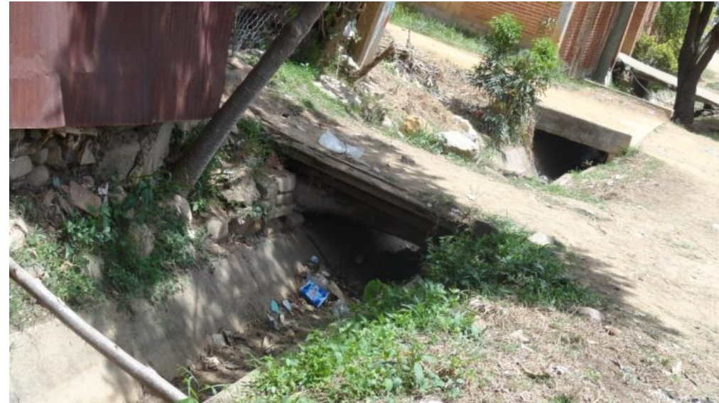
Figura 68. Canal de desagüe en la calle Independencia
