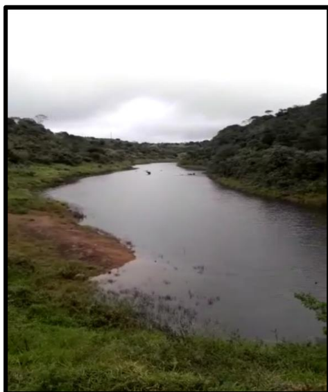
Figuras 12 e 13 - Captação – Barragem do Cafundó
