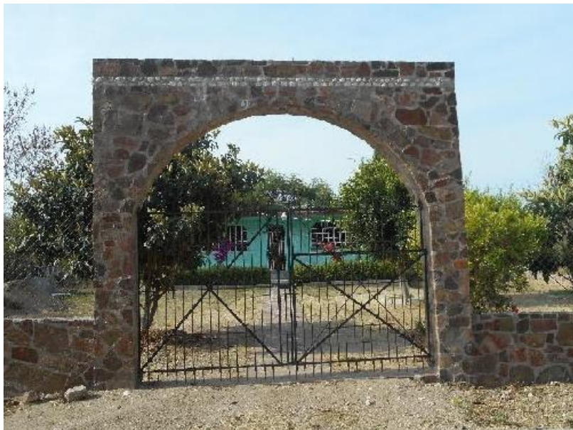
Figura 20. Construcción a base de piedra rojiza, dando una buena presentación a la vivienda.
