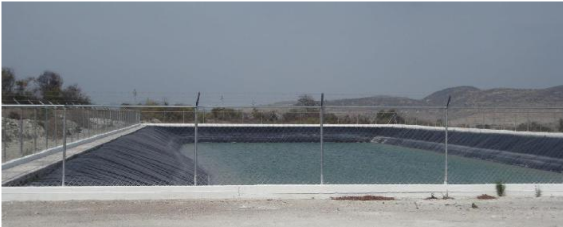
Figura 55. Olla de captación
