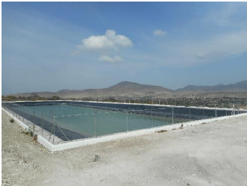
Figura 72. Obra de conservación de agua, mediante el COUSSA-2015, esta obra se ubica en el lugar Agua Dulce, Teotongo.
