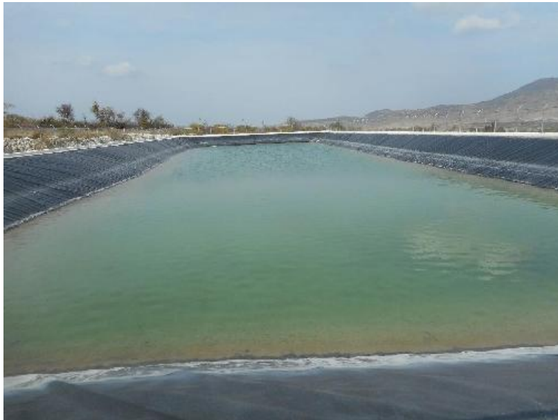
Figura 68. Sistema de captación y almacenamiento de agua de lluvia para uso agrícola.
