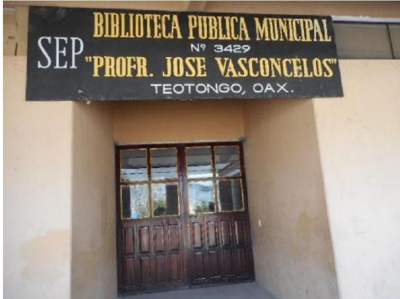
Figura 31. Biblioteca pública municipal al servicio de toda la comunidad.
