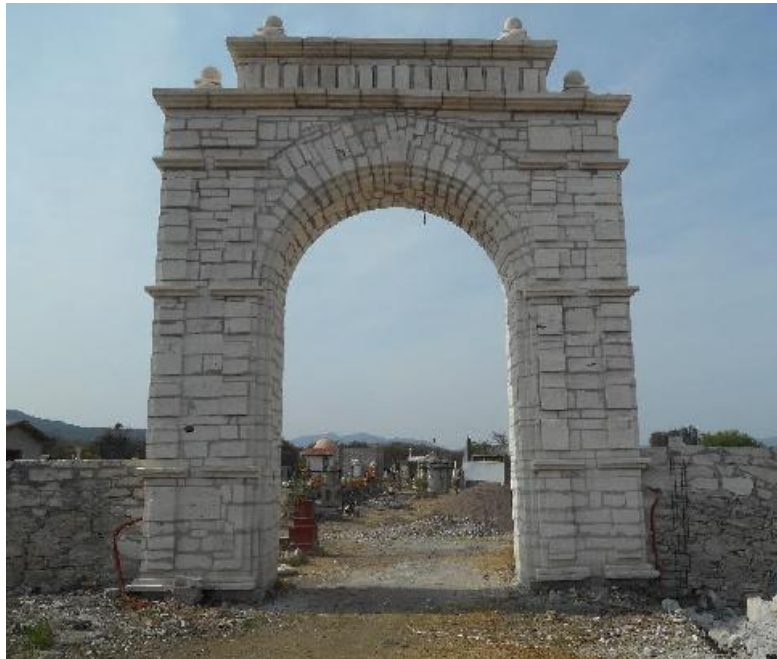
Figura 22. Arco de la entrada al panteon construida a base de material de cantera.
