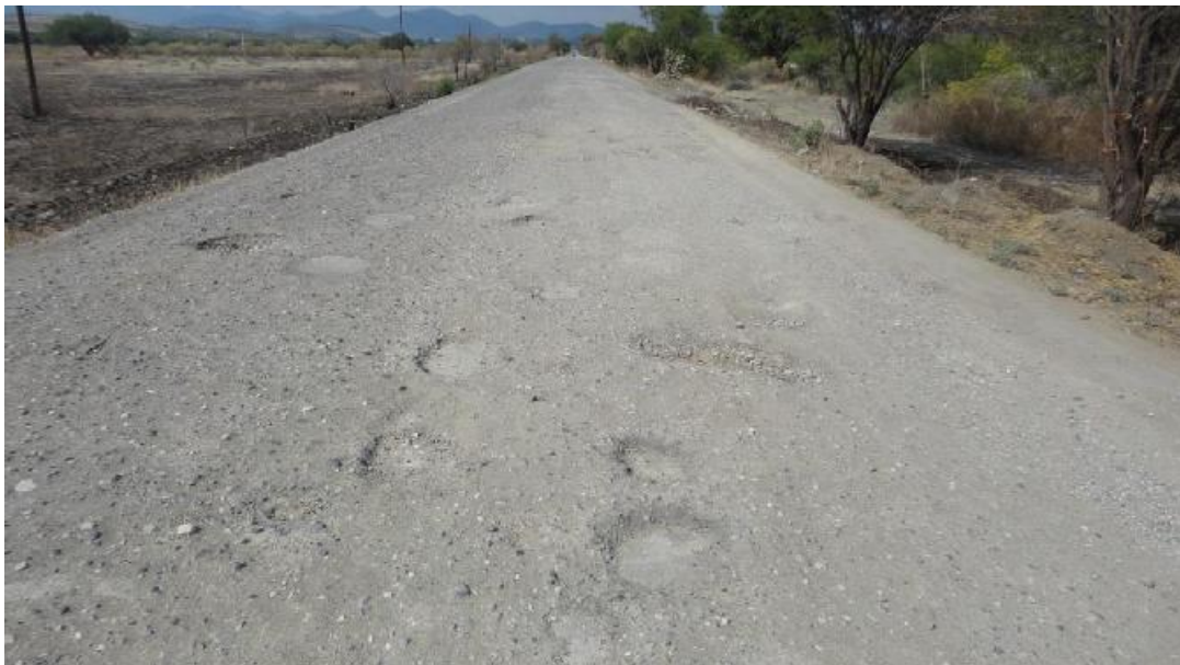
Figura 64. Carretera tramo Teotongo - Villa de Tamazulapam del Progreso
