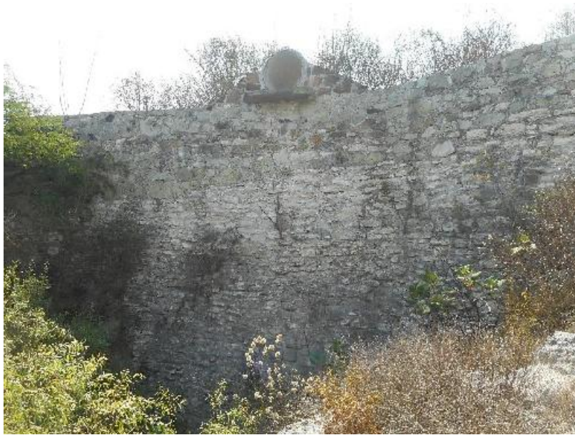
Figura 23. La piedra blanca se utiliza también para la construcción de muros de retención de tierra.
